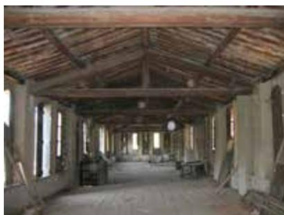
*Fig. 2. Vista interna del secondo piano della cartiera, si può distinguere la copertura con capriate lignee*
