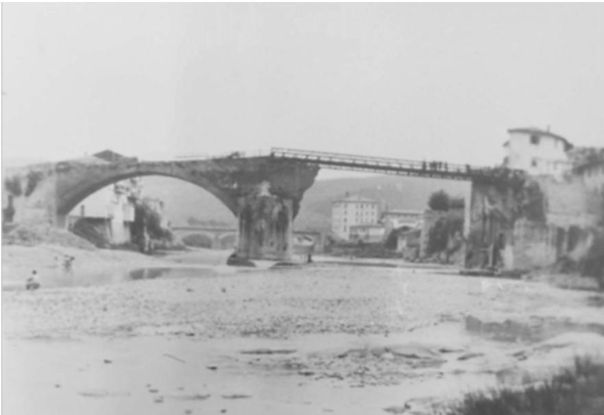
*Fig. 5. Foto storica del ponte con l'arcata minata mancante sostituita da una trave metallica, Fototeca Comunale di Pontassieve 1945 ca*
