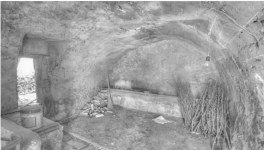
*Fig. 2. Esempio di ambiente voltato rimasto integro dopo il sisma*
