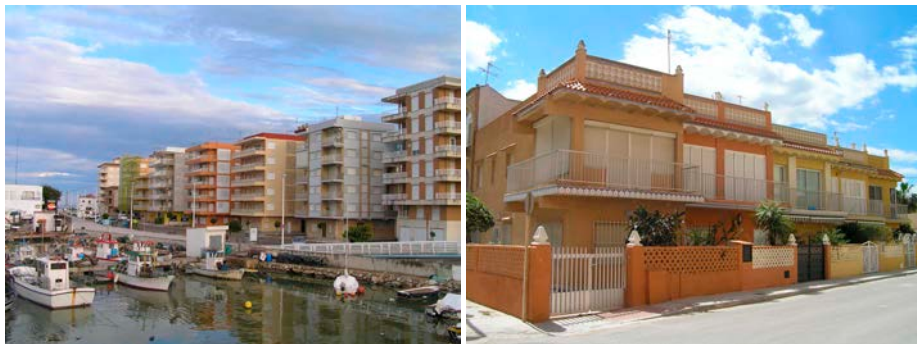
Figure 19, 20. Edifici residenziali (seconde case) non occupati (giorno infrasettimanale, mese di maggio).
