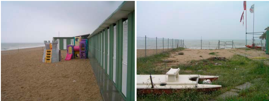
Figure 105, 106. Marcelli: a sinistra, cabine su base cementizia lungo la spiaggia; a destra, il degrado di uno stabilimento balneare fuori stagione (maggio, 2010).
