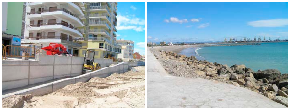
Figure 39, 40. A sinistra, la costruzione della passeggiata litoranea di El Palmares a ridosso della spiaggia; a destra, le spiagge in erosione di Pinedo a causa dell' efecto sombre del porto di Valencia, protette attraverso moli e recentemente soggette a ripascimento.
