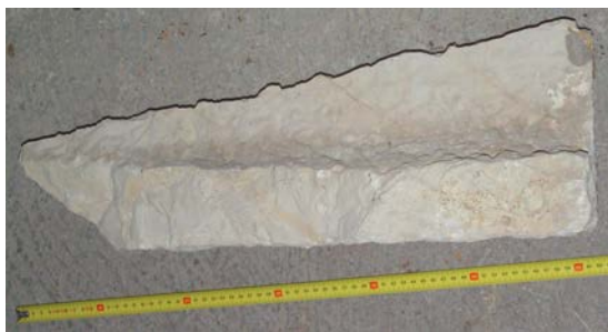
Fig. 11. Assisi, Basilica Superiore di San Francesco, braccio nord del transetto, Settore II: resti di un grande gocciolatoio in pietra (foto A. Sereni).
