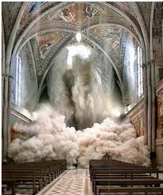
Fig. 2. Assisi, Basilica Superiore di San Francesco: il terremoto e il crollo delle volte, ripresa di P. Antolini (< http://curiosando708090.altervista.org/wp-content/uploads/2011/06/terremoto-crollo-assisi.jpg >).
