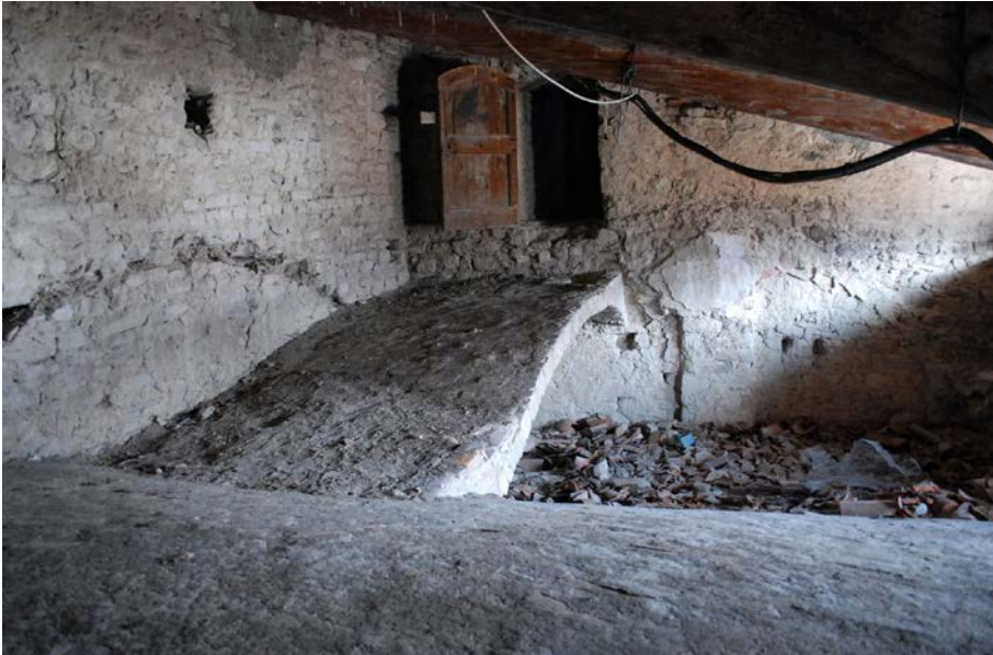
Fig. 22. Bobbio. Chiesa cattedrale di Santa Maria. Prima campata ovest, tracce di volta della tribuna.
