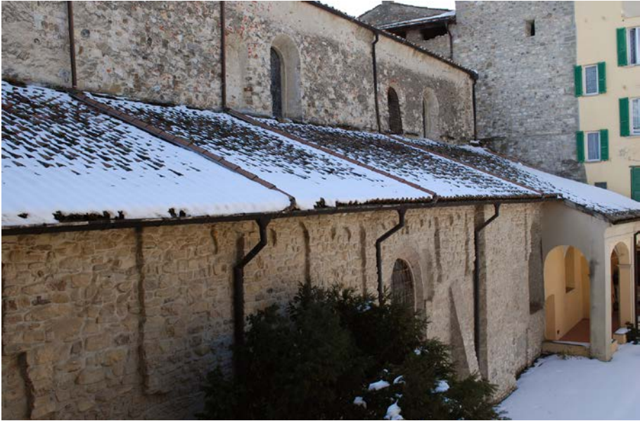
Fig. 7. Bobbio. Chiesa cattedrale di Santa Maria. Lato nord, esterno.
