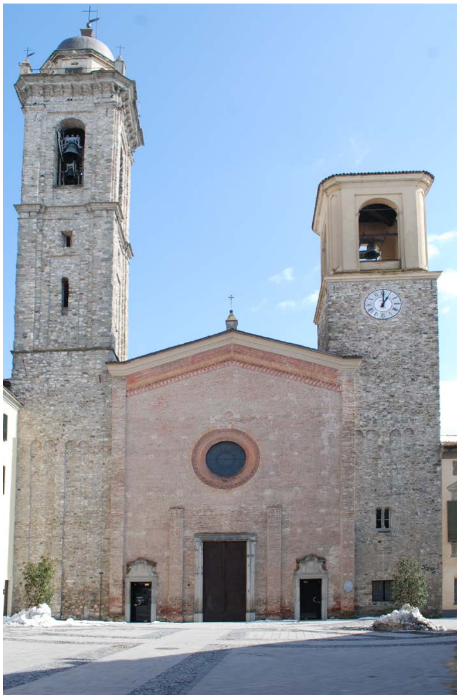
Fig. 21. Bobbio. Chiesa cattedrale di Santa Maria. Facciata (stato attuale).
