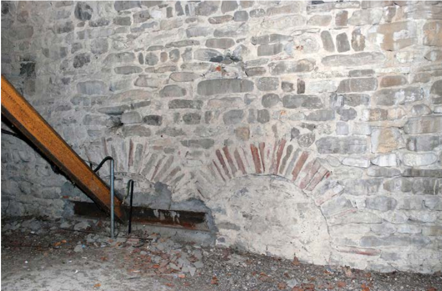
Fig. 19. Bobbio. Chiesa cattedrale di Santa Maria. Parete sud dell'incrocio tra navata e transetto, bifora occlusa.
