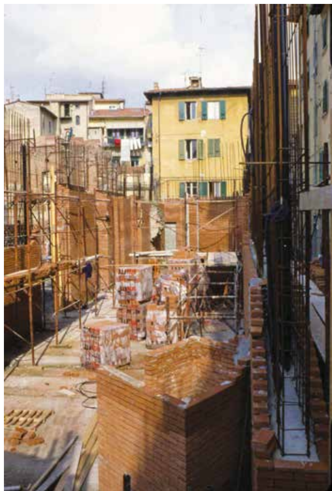
S. Michele in Borgo, immagine durante la fase di cantiere
