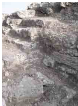
Figura 9. La scala a sud-est, al piano superiore.
