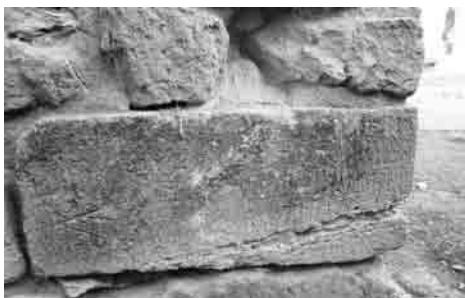
Figura 6. I mason's marks del corridoio.
