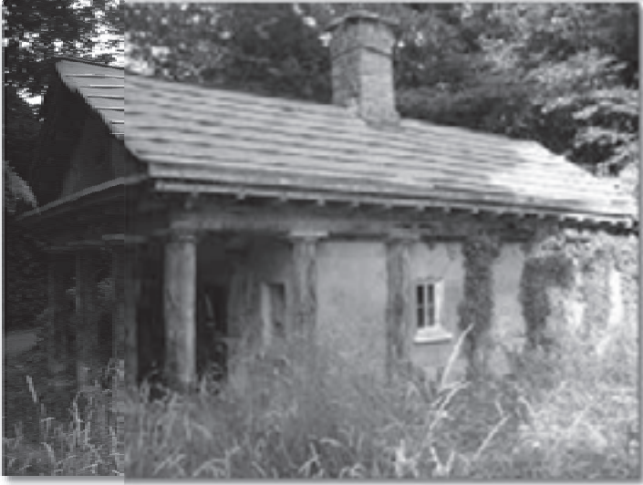
Fig. 6. Il padiglione Belline in un dettaglio.
