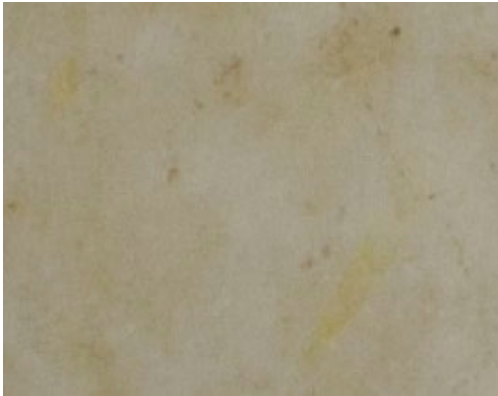
Figura 34. Elementi di colore giallo nella parte sinistra della lastra
