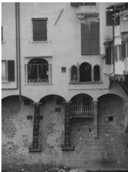
Fig. 38 Particolare della fig. 38 con due finestroni sopra gli sporti e il terrazzino sottostante. (Foto: P. Focarile)
