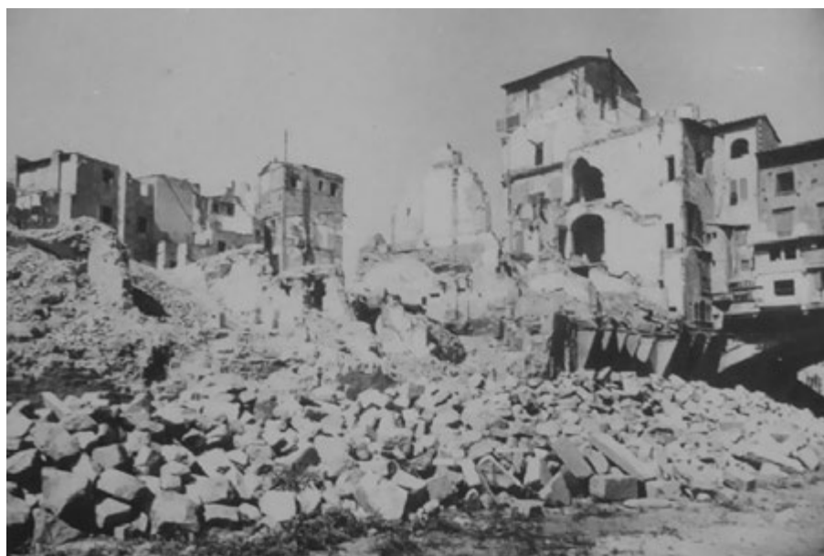
Fig. 34 Veduta delle macerie di Palazzo Mannelli riprese dall'Arno, 1944-1945. (Foto: Su concessione del Ministero dei Beni e delle Attività Culturali e del Turismo / Firenze. Soprintendenza ai Beni Architettonici )
