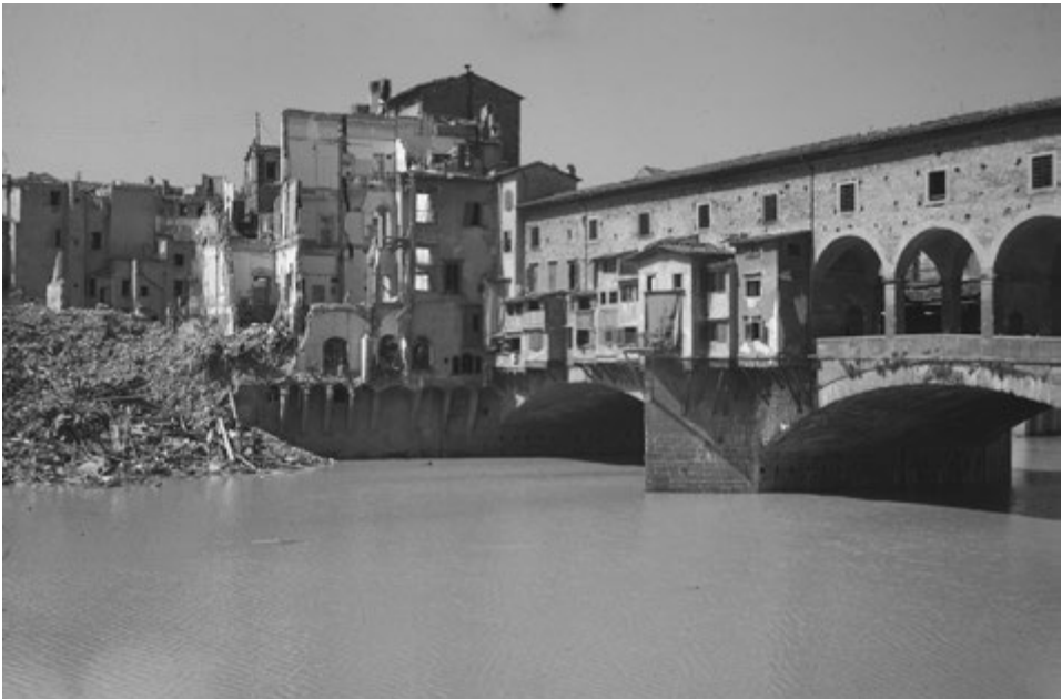
Fig. 35 Veduta delle macerie di Palazzo Mannelli riprese dalla parte opposta dell'Arno, agosto 1944. Londra, Imperial War Museum. (Foto: © Imperial War Museums)
