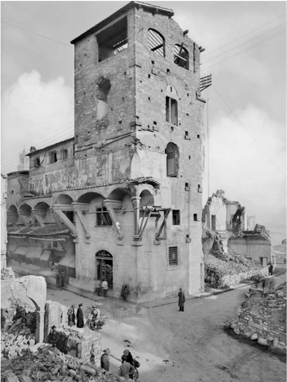
Fig. 30 Veduta della Torre dei Mannelli dal canto dei Guicciardini dopo il crollo dell'abitazione adiacente, inverno 1944. (Foto: © Archivi Alinari)
