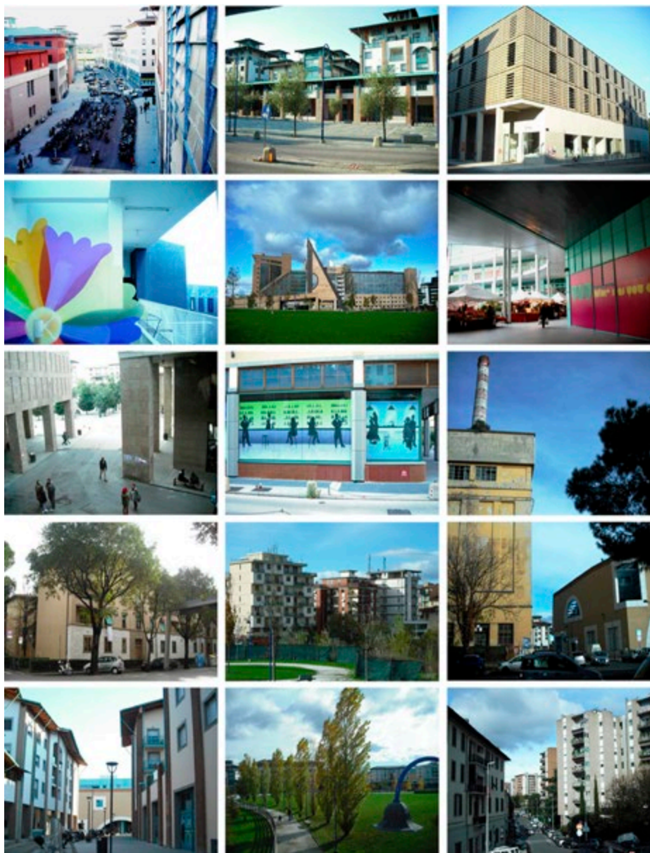
Figura 3. Immagini del quartiere di Novoli e dell'area San Donato.
