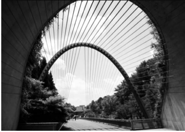
Figura 11 – Ponte e struttura in acciaio sospesa all'esterno del Miho Museum presso la città di Shigaraki in Giappone.
