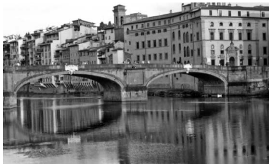
Figura 2 – Ponte Santa Trinita a Firenze, progettato e costruito tra il 1566 e il 1571 da Ammannati. Fu distrutto nel 1944 dalle truppe tedesche, poi ricostruito e inaugurato nel 1958.
