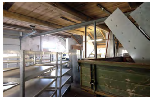
4-166 (oben) – Fachhallenhaus (Feldseite) mit verschiedenen Dachformen und -deckungen. Lüder, 2018. 4-167 (mitte links) – Dachboden Fachhallenhaus mit teilweise erneuerten Konstruktion. Lüder, 2018. 4-168 (mitte rechts) – Holzstützen ersetzt durch Mauervorlagen und Stahlkonstruktion. Lüder, 2018. 4-169 (unten rechts) – Wirtschaftsteil Fachhallenhaus mit neuem Tor. Lüder, 2018.
