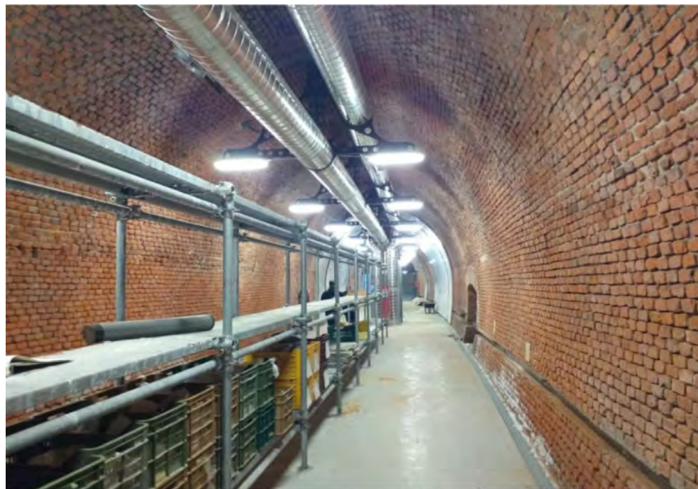
Figure 6. Interior of the Velia railway tunnel ( https://www.museopaestum.beniculturali.it/progetto-di-intervento-dell'ex-galleria-ferroviaria-a-velia/ ).
