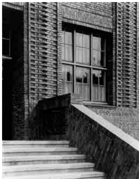
Treppenwange, Gebäude der Kulturwissenschaftlichen Bibliothek, Heilwigstraße 116
