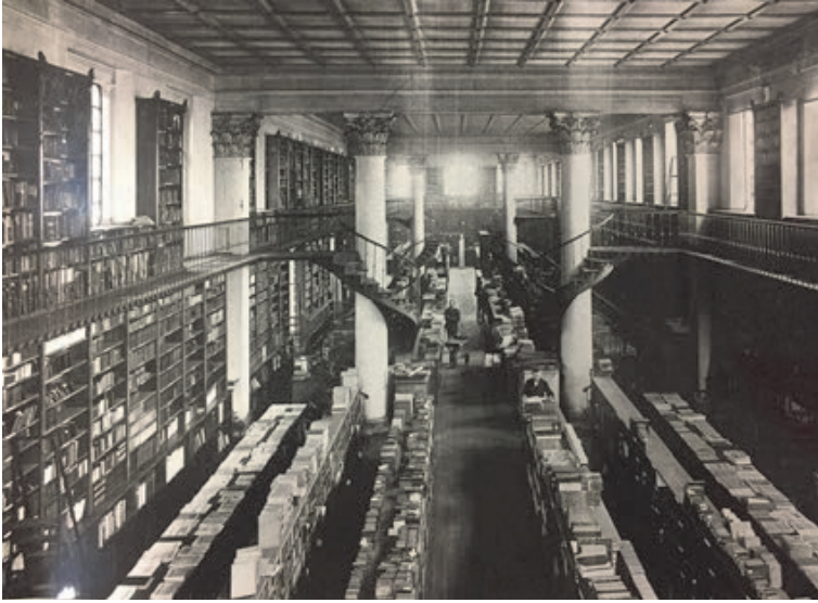
Abb. 2: Blick in den Hauptlesesaal der damaligen Stadtbibliothek Am Speersort, 1905, SUB.
