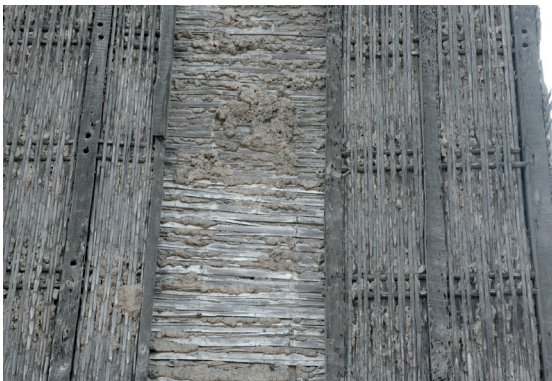
Fig. 4.3 (Below) Lima. Peru. Quincha wall.
