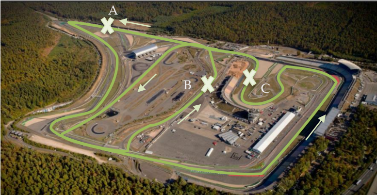
Abbildung 3.26 Luftaufnahme des Hockenheimrings mit gewählter Streckenführung für den Feldtest. Die Kreuze kennzeichnen die Positionen der Positionen der Hindernisse. Aufnahme: webbaviation.de
