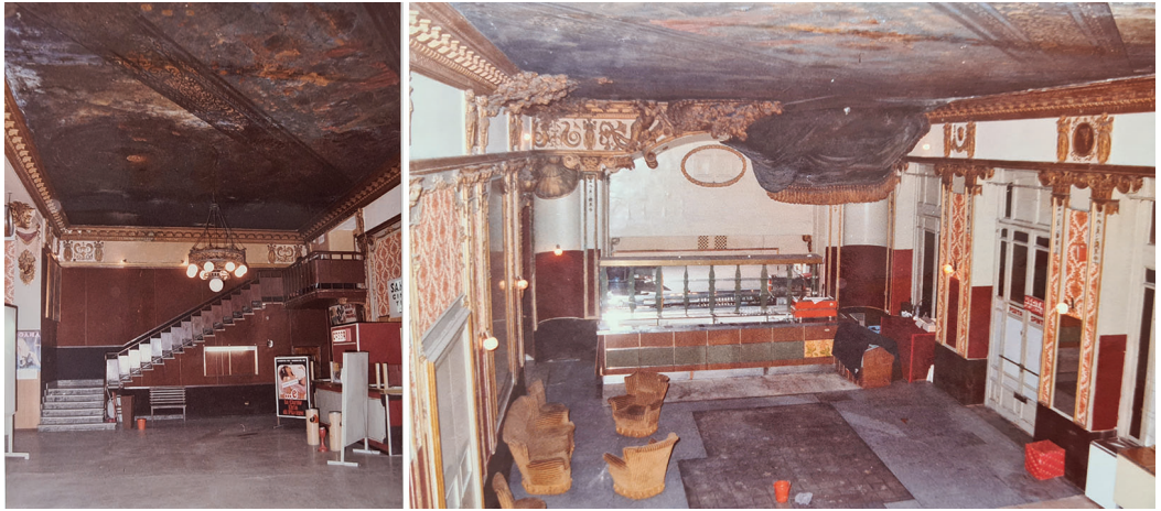
Fig. 02. Foto storiche del Café Chantant che testimoniano la presenza della scala, demolita durante i lavori del 1990, e sul lato opposto la zona bar (Archivio fotografico della Soprintendenza dei Beni Culturali ed Ambientali di Catania, foto n. 82957 e 82968, scattate nel 1987 da Salvatore Lombardo).
