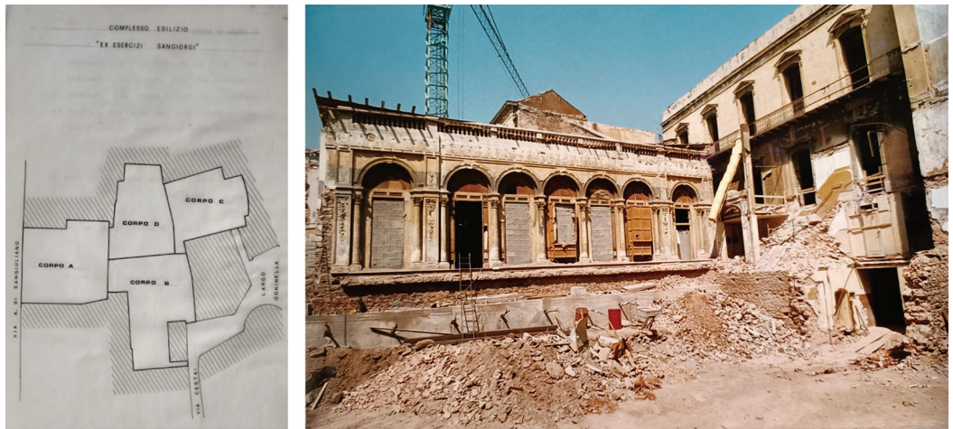
Fig. 08. Individuazione in planimetria dei corpi interessati agli interventi di restauro e ristrutturazione (sn) e lavori di sbancamento della sala per la realizzazione della platea a quota ingresso strada (ds) (Archivio dei Progetti, Fondo Matteo Arena, Università degli Studi di Catania, SDS Architettura, Siracusa).
