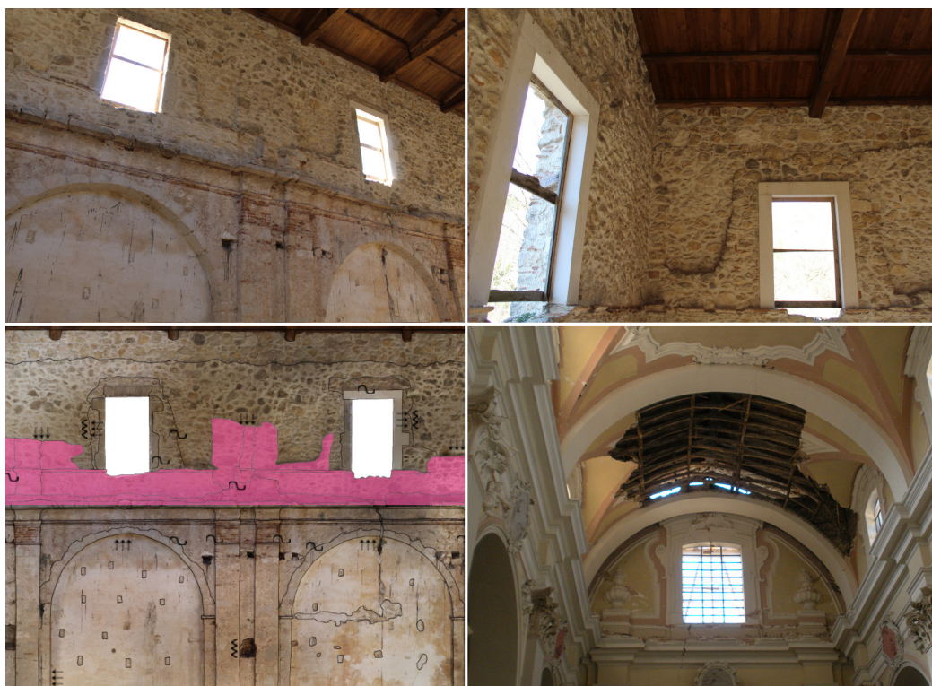
Fig. 04. In alto immagini di dettaglio della muratura di Santa Maria della Vittoria, in basso a sinistra analisi archeologica e a destra confronto tipologico con la chiesa di San Domenico a L'Aquila (immagini ed elaborazione grafica degli autori).
