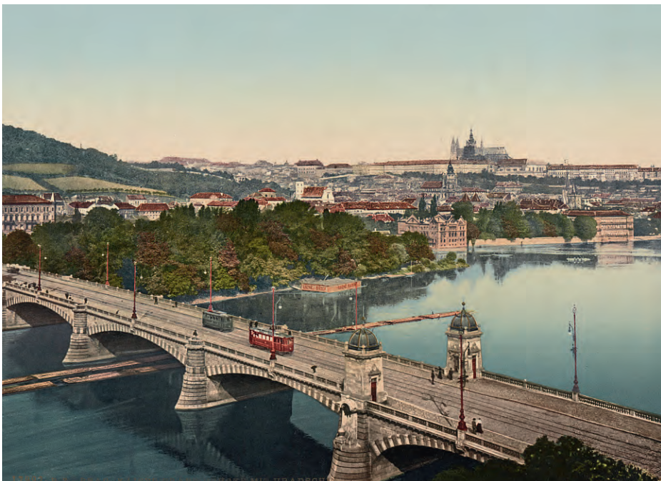
Kaiser-Franz-Joseph-Brücke (heute: Brücke der Legionen) im Stadtteil Hradčany in Prag. LOC
