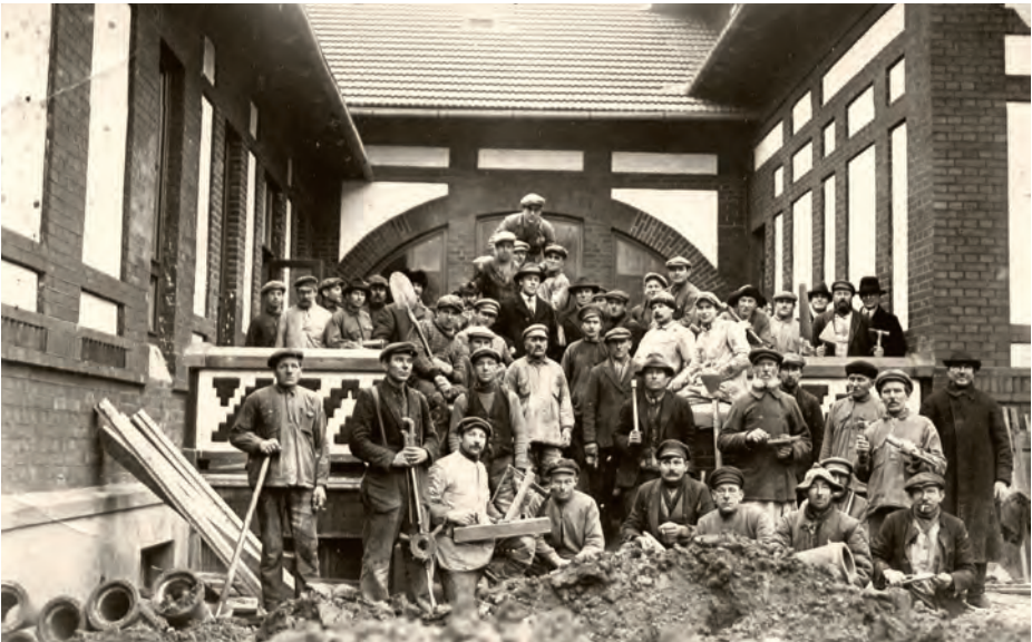
Die Ausführenden der Umbauarbeiten am Haus des Estnischen Studentenvereins (Saalanbau, Architekt Johann Ostrat), ca. 1929. EAM AR 24.7.6.
