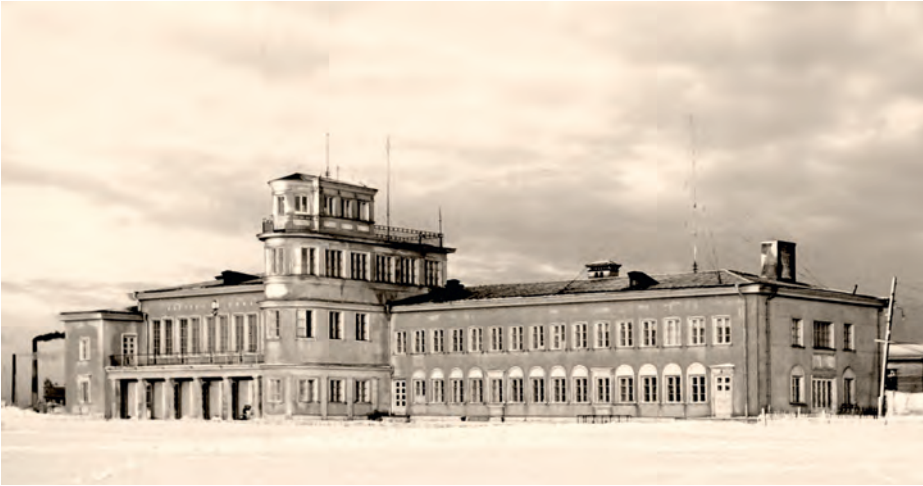
1939 entwarf Arthur Jürvetson gemeinsam mit Roman Koolmar das Hauptgebäude des Tallinner Flughafens (fertiggestellt 1959). EAM Fk 237
