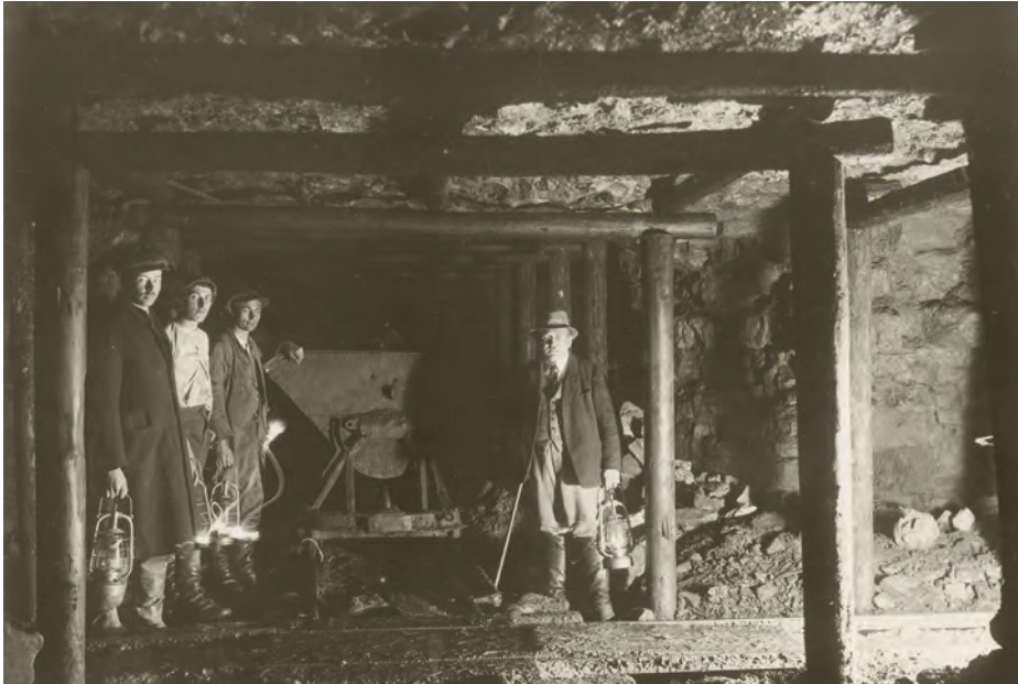
Die Brennschiefergrube von Kukruse in den 1920er Jahren. Erster von links Ingenieur Karl August Feldveber. EAA.2111.1.14117.1
