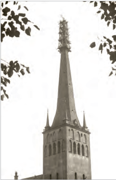
Restaurierung des Turms der Oleviste-Kirche. EFA
