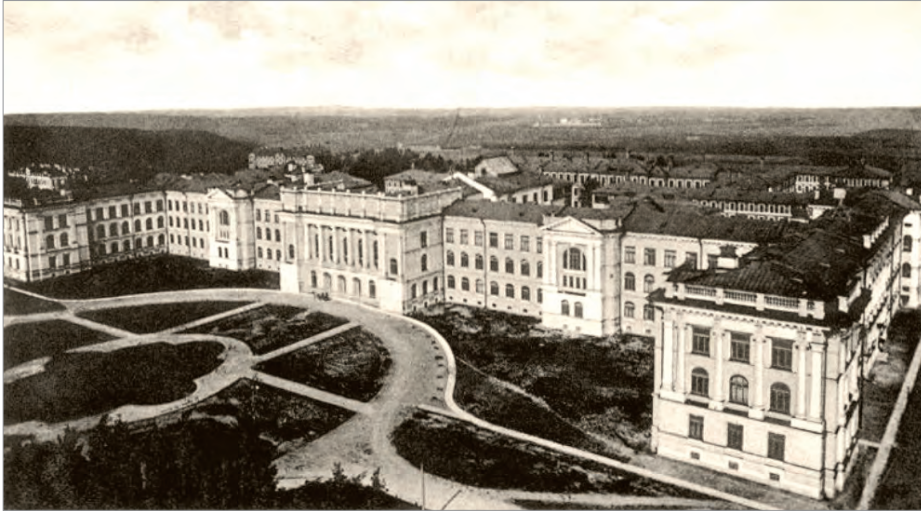
Des 1902 fertiggestellte Hauptgebäude des Polytechnischen Instituts von Sankt Petersburg im Jahre 1912
