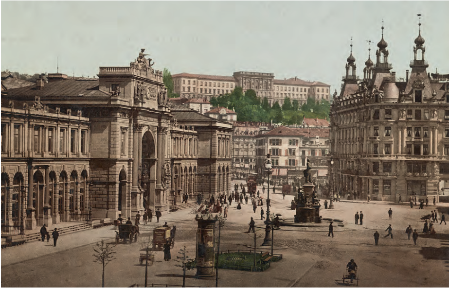
Bahnhofplatz und Polytechnikum. LOC
