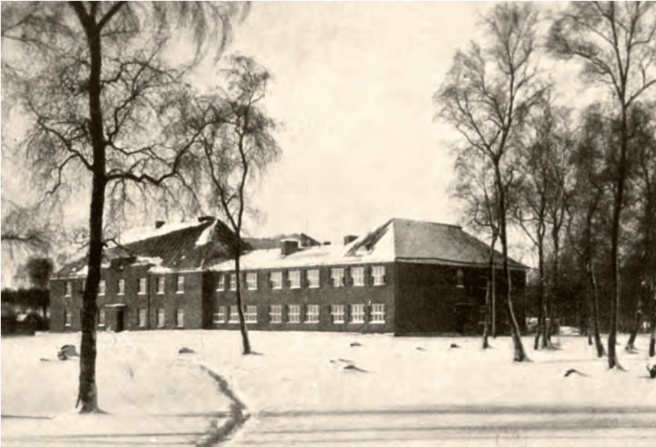
Das 1932 fertiggestellte Gebäude für eine Grundschule und das Volkshaus in Kunda. Ingenieure waren Max Grasberg und Johannes Liibant. EFA 301.0.54975
