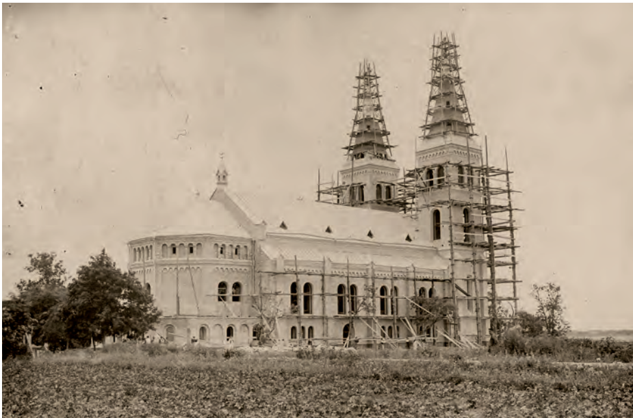
Bauarbeiten an der von Axel von Howen entworfenen Kirche von Rapla (ursprünglicher Entwurf von Rudolf von Engelhardt), ca. 1901. AM F 16383
