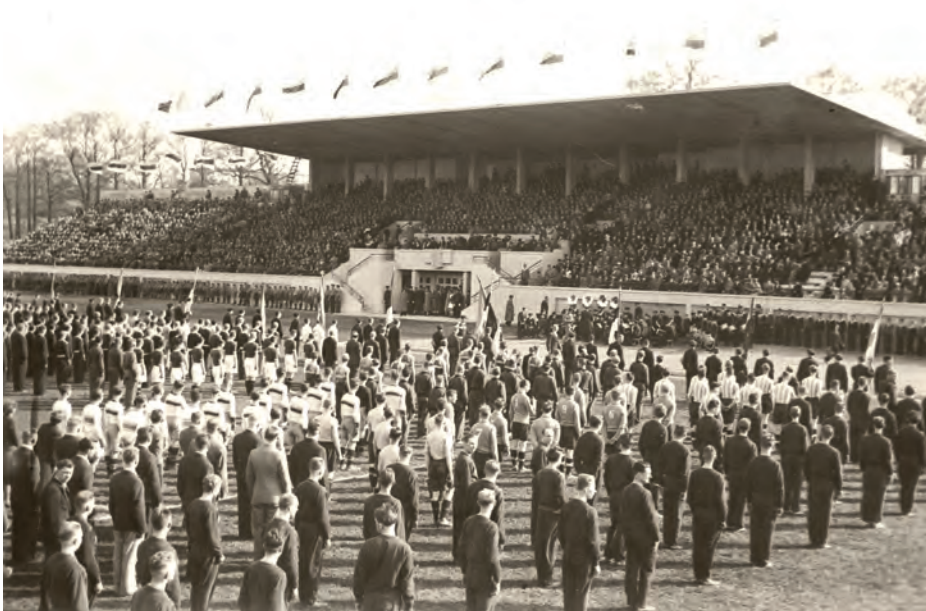
Eröffnung der neuen Spannbetontribüne im Stadion von Kadriorg 1938. Die vorragende Konsole der Tribüne betrug 12 m und war zu jener Zeit die längste in Europa. EFA.2.0-27852
