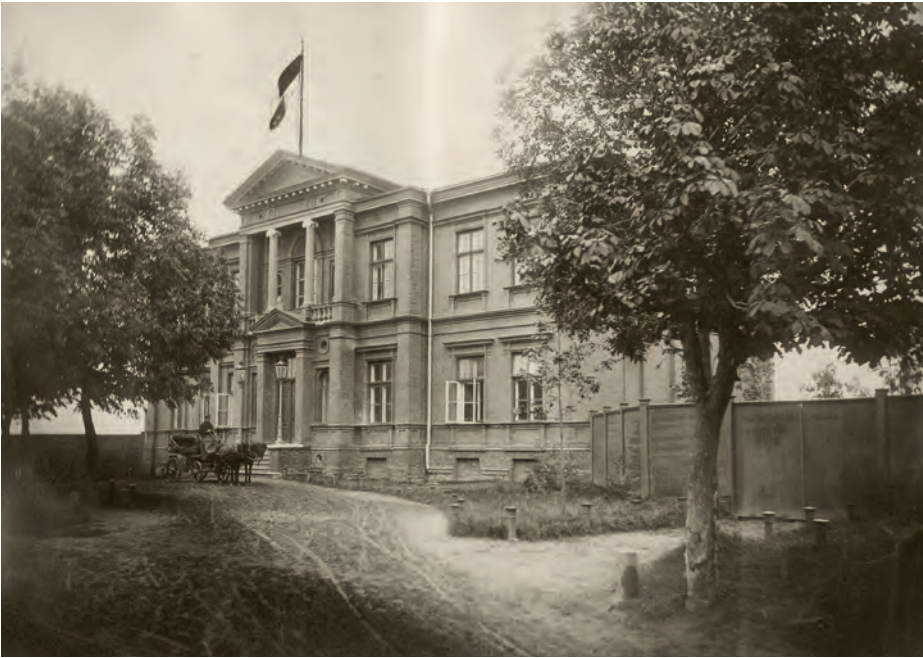
Konventsgebäude der Korp! Estonia in Tartu, 1886 entworfen vom Architekten Reinhold Guleke. EAA.1423.1.196.128
