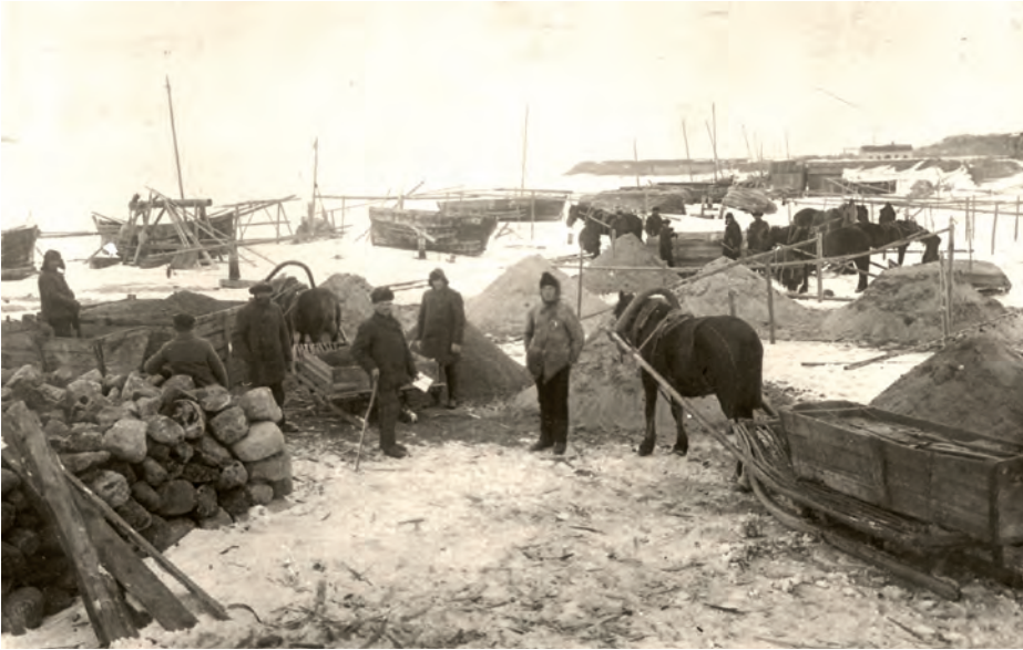
Bauarbeiten im Hafen von Paldiski, 1920. EFA.330.0-63256
