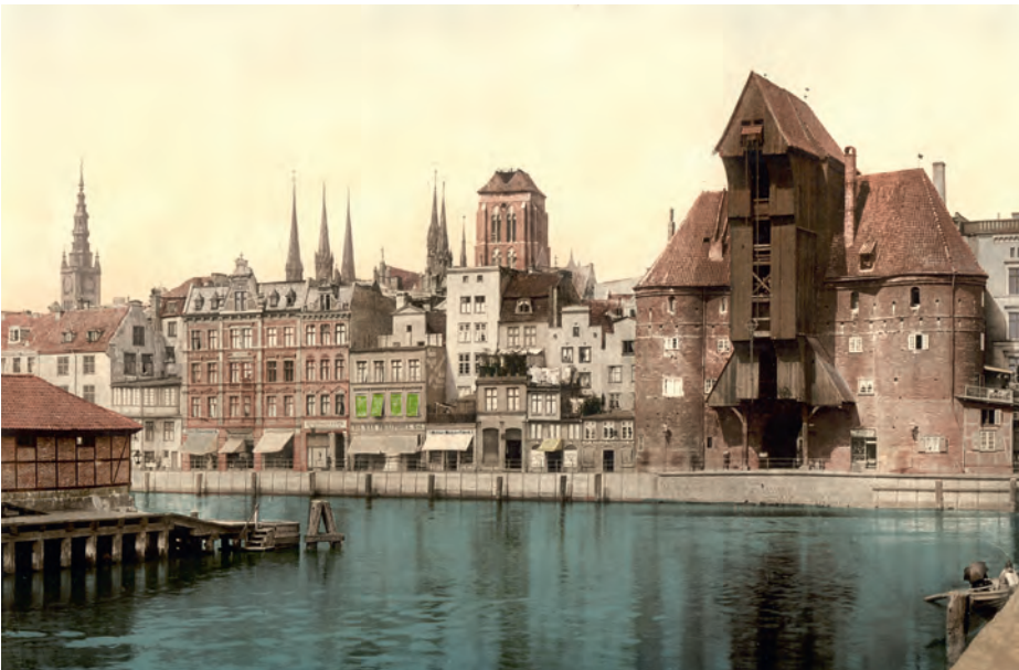
Der Danziger Binnenhafen. Im Vordergrund das Krantor, im Mittelalter der größte Kran Europas mit einem Tretradantrieb. LOC
