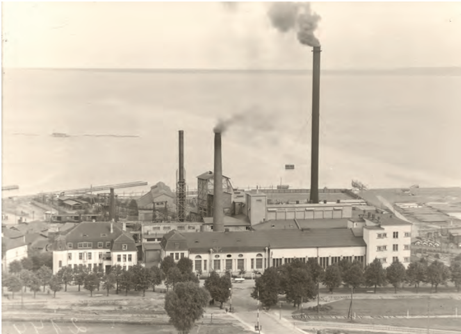
Das Tallinner Elektrizitätswerk 1930. EFA.10.4.2144
