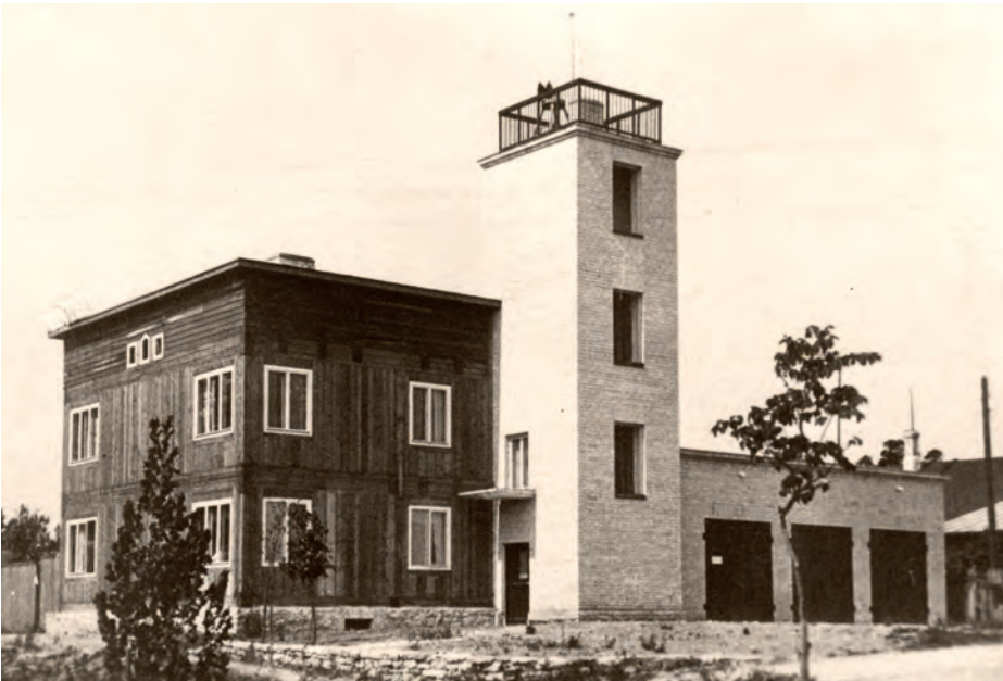
Feuerwache von Nõmme. Architekt Friedrich Wendach. EAM Fk 3079
