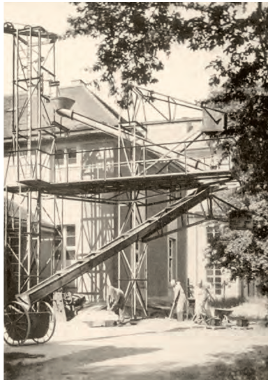
Versuchsanstalt für Beton und Eisenbeton, ca. 1930. KIT-Archiv 28010: I/1347
