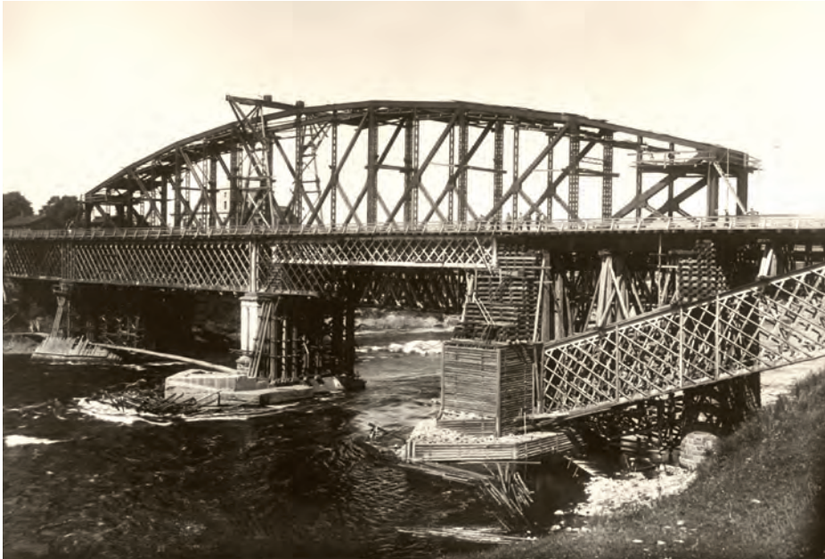
Der Bau der Eisenbahnbrücke von Narva im Jahre 1923. Der Entwurf der Brücke stammt vom polnischen Ingenieur Andrzej Pszenicki, Leiter der Bauarbeiten war Ottomar Maddison. EFA 117.A-13-2
