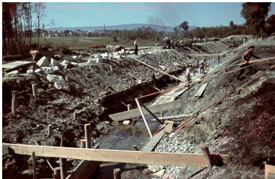
Abb. 3.27: Aeschi SO, Burgäschisee-Nord. Bau des neuen Seebachkanals. Aufnahme: Ernst Klöti, 1943. Zentralbibliothek Solothurn / Diasammlung Ernst Klöti, FS D 3/1403.
