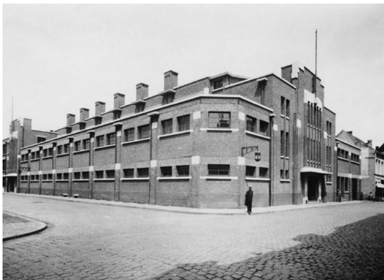
Figure 9. Piscine de la Veldstraat, 1934 (AVA, GP#4027)
