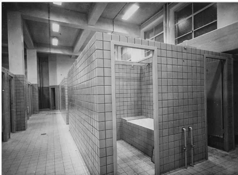
Figure 19. Bains de Bruxelles. Intérieur d'une cabine de baignoire, s.d. (AVB, C-15023)
