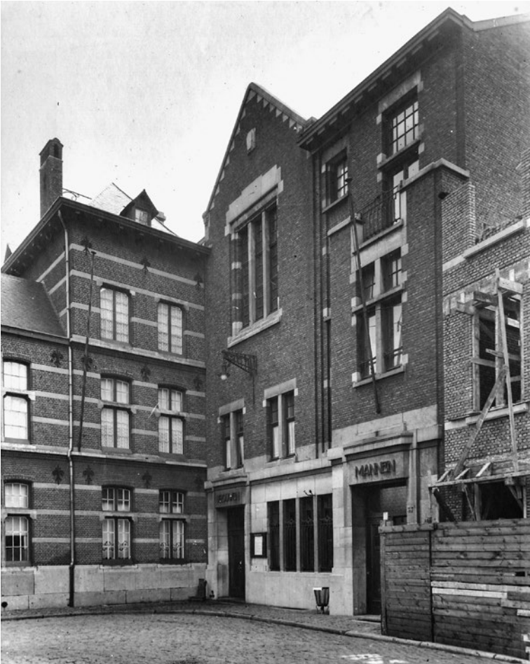
Figure 8. Bains et buanderie de la Wilgenstraat, 1938 (AVA, FOTO-OF#2698)
