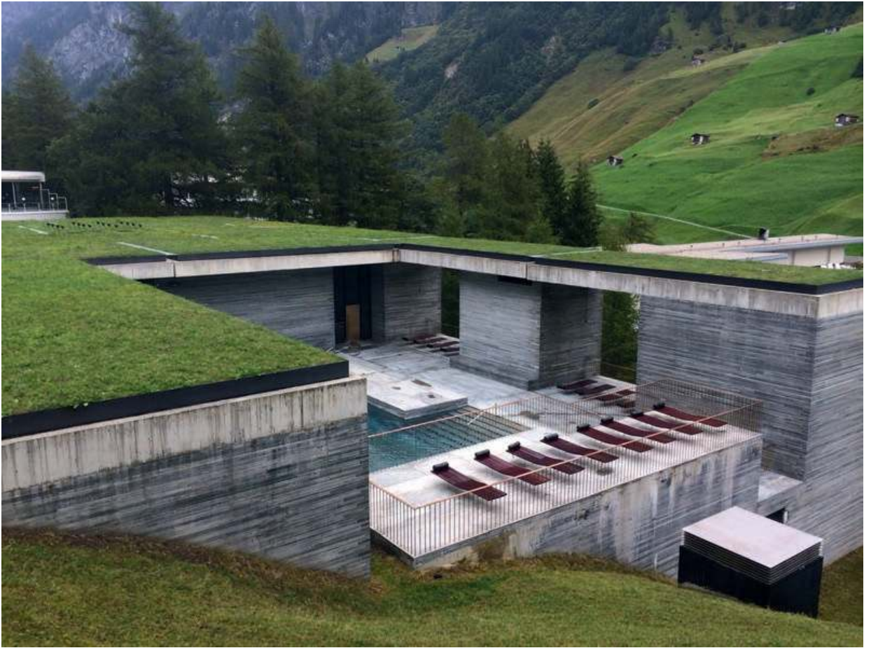
Abb. 12: Therme in Vals, Ansicht des Außenbereichs.
