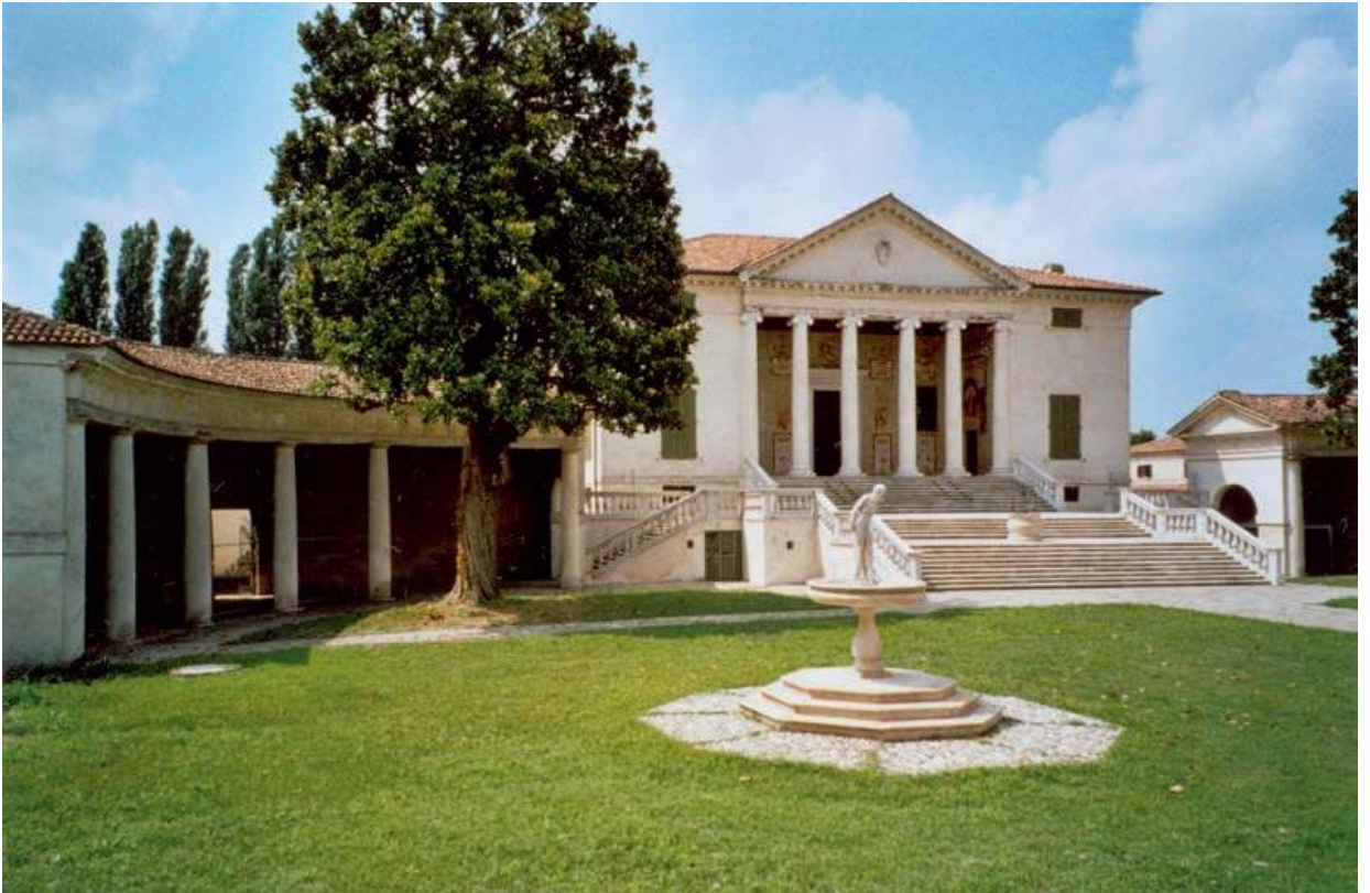
Abb. 12: Villa Badoer in Fratta Polesine (Rovigo), Architekt: Andrea Palladio (1556/57–1563).
