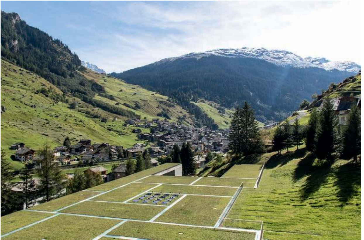
Abb. 1: Therme in Vals, Gesamtanlage, Blick über die Bedachung mit Lichtschlitzen nach Süden ins Valsertal.
