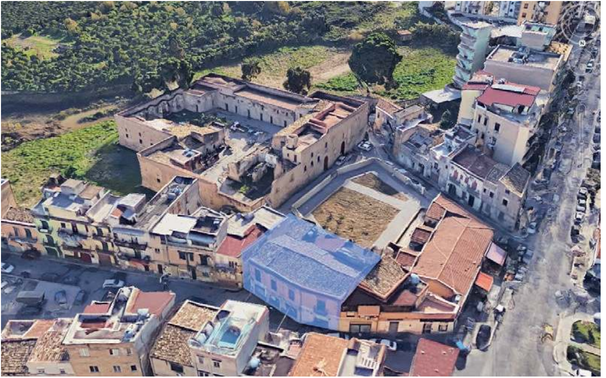
Abb. 15: Luftaufnahme des Palastes der Favara, Palermo, 2017 (Quelle: Google Earth (5.5.2017), ursprüngliche Lage des Bades vom Autor blau markiert).
