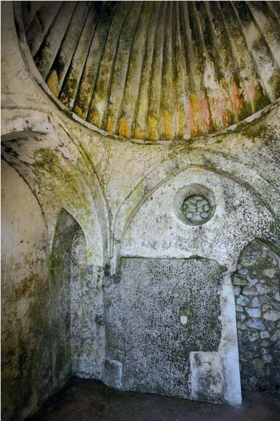
Abb. 29: Innenraum des Bades der Villa Rufolo in Ravello, 2. H. 13. Jh. (Quelle: Foto des Autors).
