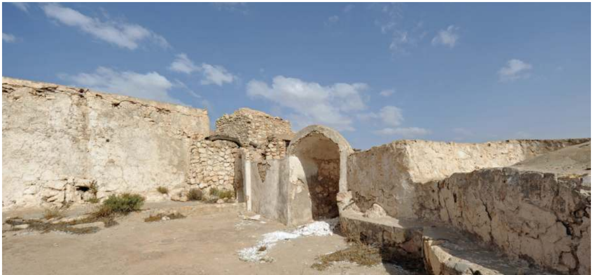
III. 110. La mosquée d'Atūghasrū, la cour et son mihrab
