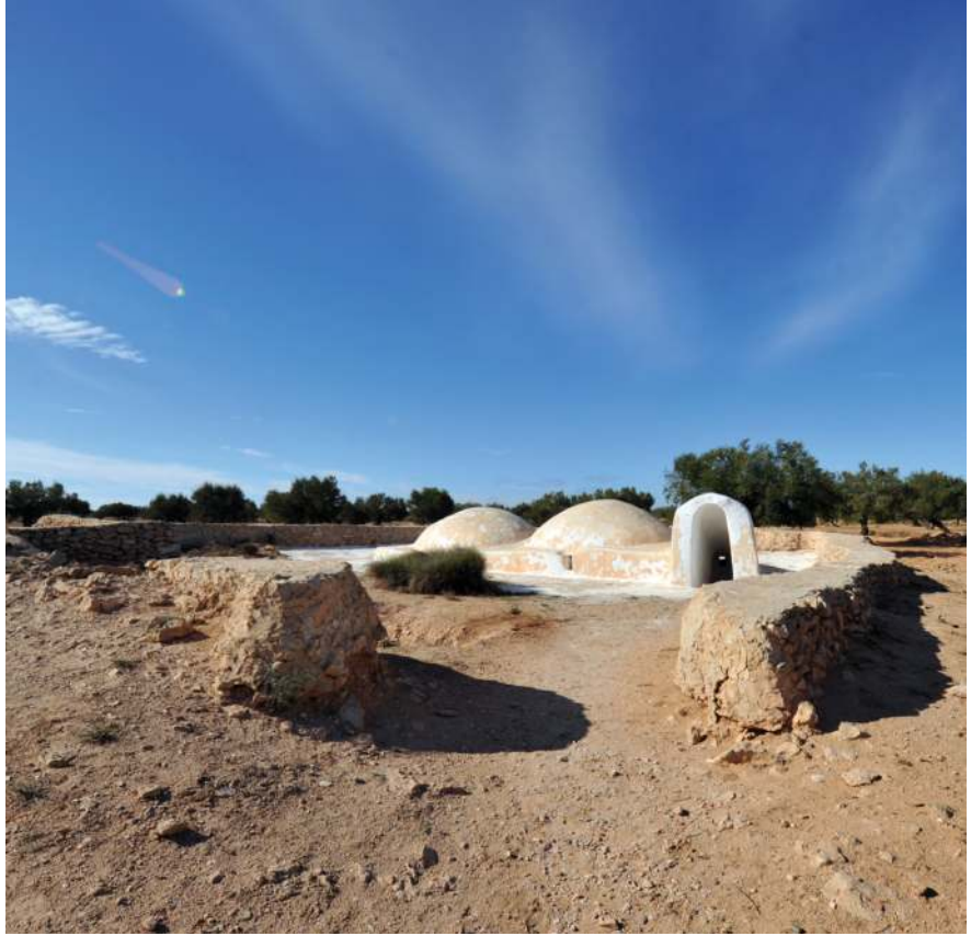
III. 124. Mosquée souterraine de Sadwikish à Djerba (A. Derriks, Djerba, janvier 2010)
