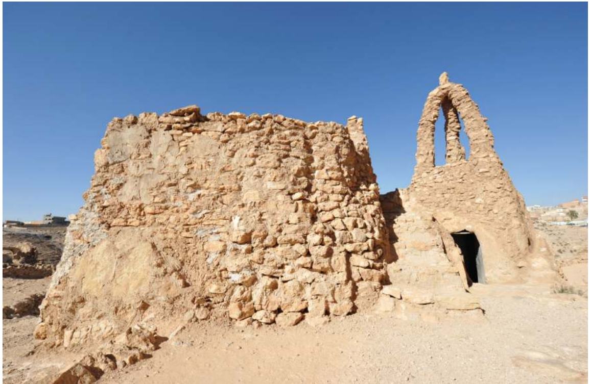
Ill. 19. La mosquée du grenier fortifié de Nālūt
