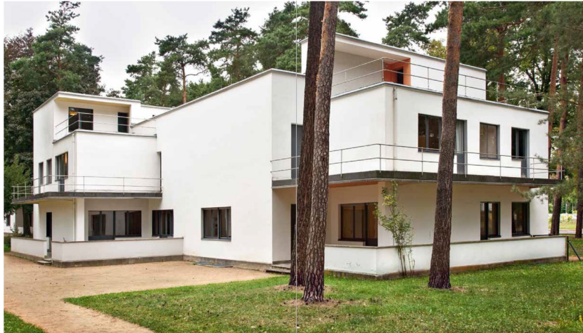
Abb. 4: Doppelhaus Muche/Schlemmer – nach dem Wiederaufbau circa 2010 (Bednorz/Plachta 2014:170f)
