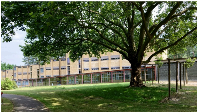
Abbildung 4: Rückseite Seminartrakt und Glasgang. Im Vordergrund die von Meyer gepflanzte Platane (Foto: Wendeburg 2021)
