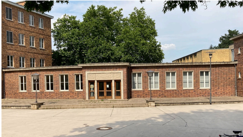
Abb. 10: Waterstradt'scher Verbindungsgang (Foto: Wendeburg 2021)
