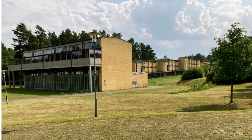
Abb. 8: Nordansicht Bibliothek. Im Hintergrund Glasgang mit Seminargebäuden (Foto: Wendeburg 2021)
