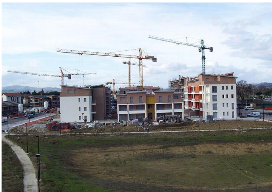
Fig.1: Vista degli edifici del quartiere durante la fase di costruzione. Fonte: camangiassociati.it (2015)
