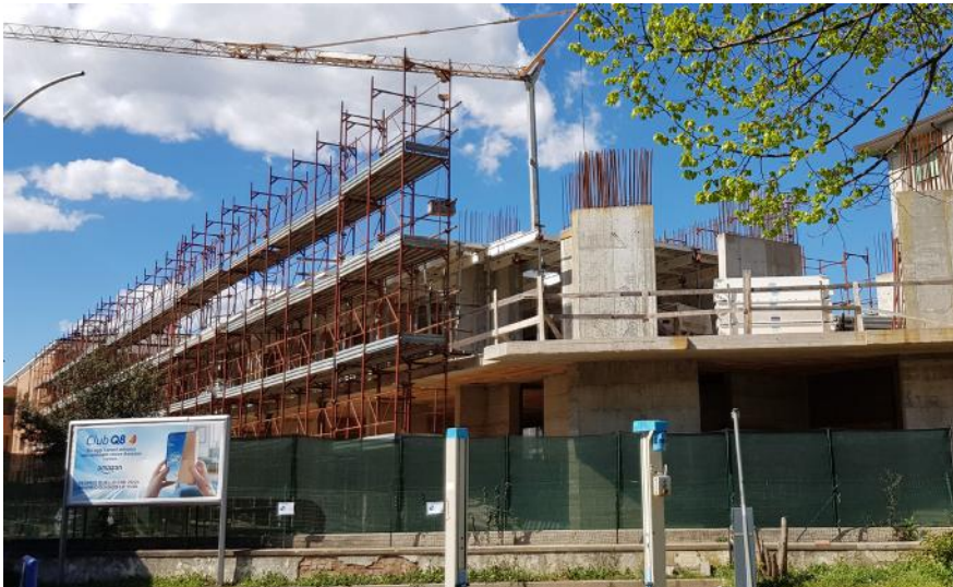
Fig.2: Vista degli edifici del quartiere durante la fase di costruzione. Fonte: arch. Fabrizio Amadei (n/d)
