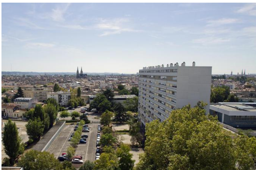
Fig.1: Vista dell'edificio H del complesso di edifici residenziali G, H, I, riqualificati su progetto dello studio Lacaton & Vassal. Fonte: Mairie de Bordeaux (2018)
