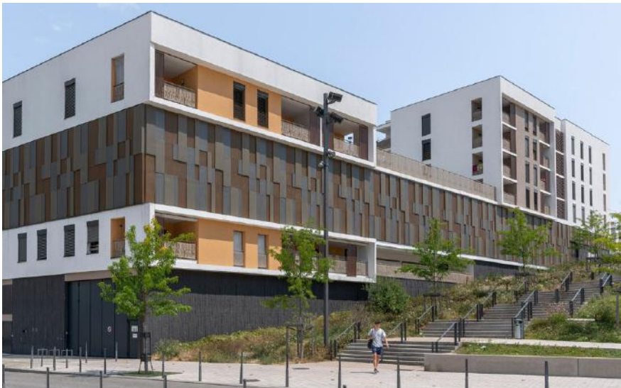
Fig.2: Vista di alcune unità abitative collettive in affitto sociale e di un'area commerciale. Fonte: Atelier Thierry Roche (2015)
