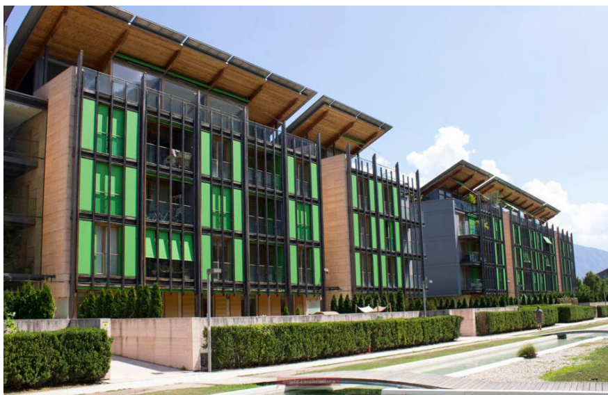
Fig.1: Vista degli edifici del quartiere. Fonte: amatelarchitettura.com (2022)
