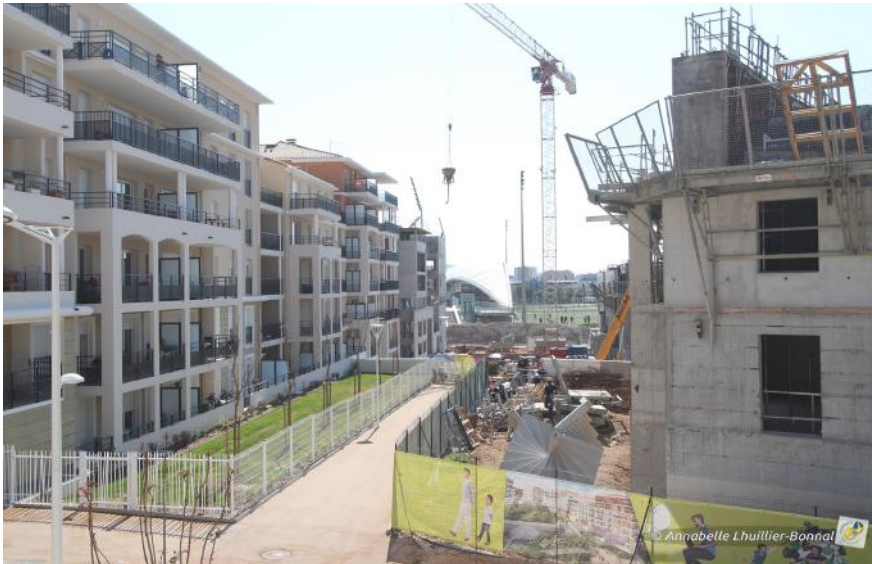
Fig.2: Vista degli edifici in costruzione nel quartiere. Fonte: toulon.fr (2017)
