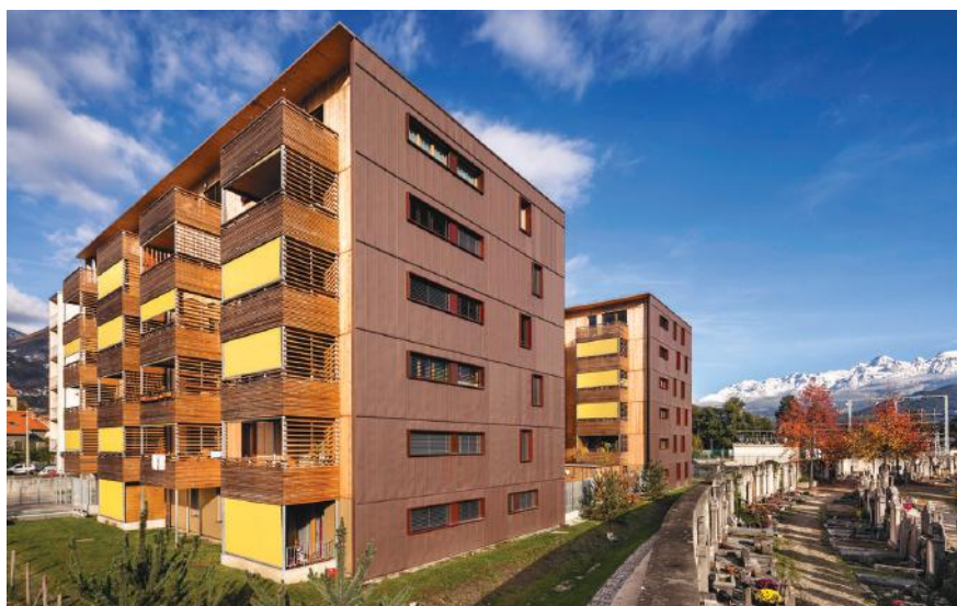
Fig.1: Vista degli edifici, i cui involucri sono progettati con particolare attenzione rivolta ai dispositivi bioclimatici passivi. Fonte: construction21.fr (2016)
