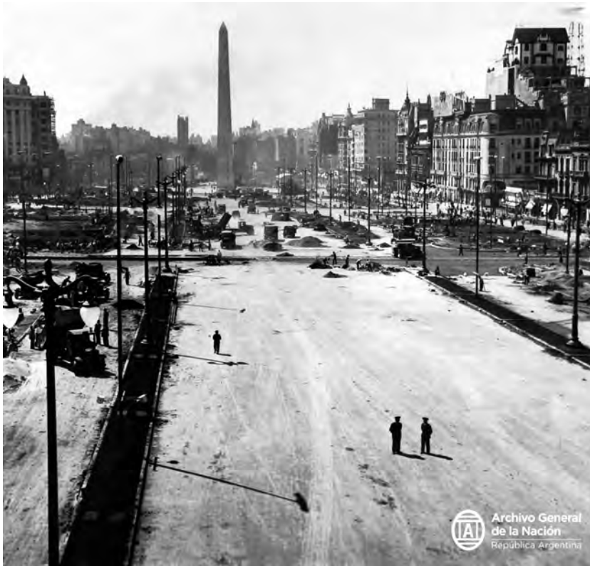
Obras en la avenida 9 de Julio. Buenos Aires, octubre de 1937. Archivo General de la Nación. Documento fotográfico. Inventario 4379.
