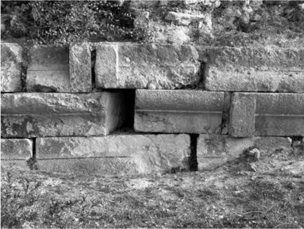
Abb. 9: Spoliensockel des zweiten Mauerringes aus Sitzstufen des Theaters von Anazarbos (Abb. R. Posamentir).
