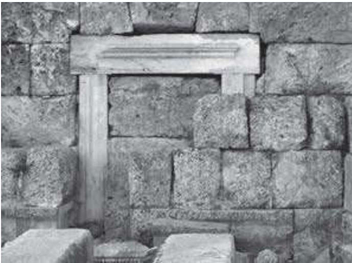
Abb. 13: Perge. Bogentor, zugesetzter Durchgang (Abb. W. Martini).
