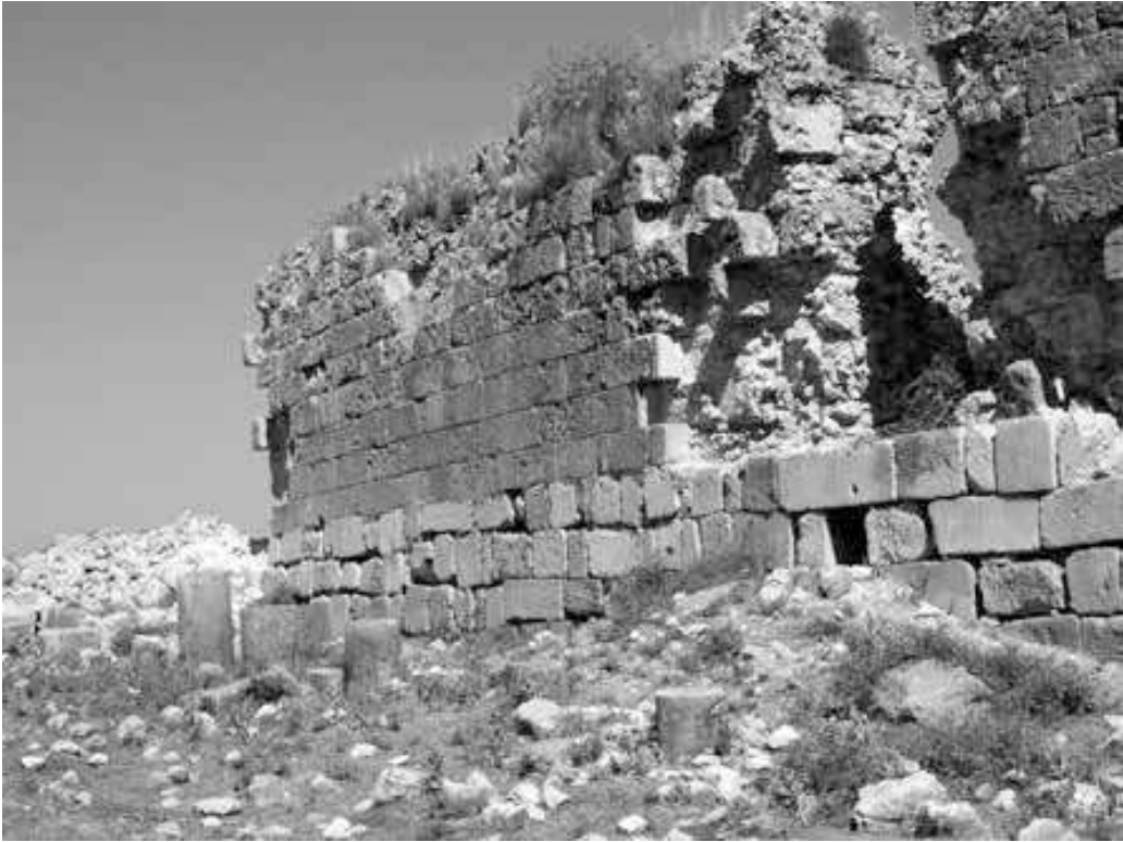
Abb. 10: Spoliensockel des zweiten Mauerrings mit späterem (?) Aufbau aus leichten Tuffsteinen (Abb. R. Posamentir).
