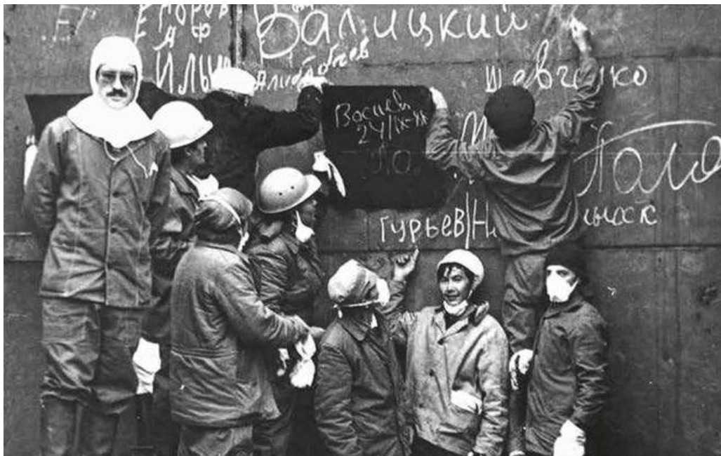
Abb. 4: Graffitis der Mangyšlaker Liquidatoren auf einer Wand des vierten Reaktorblocks in Černobyl'. Rechts oben der Stadtname „Ševčenko“. Aus den Bildbeständen des GAMO.
