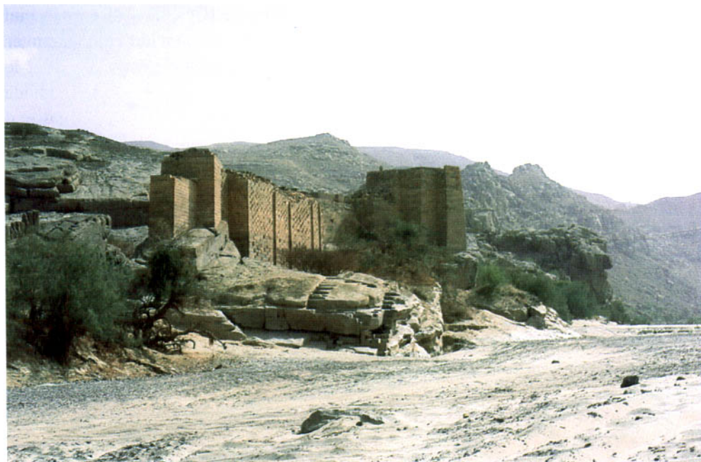
168 - Ancrage Est du barrage de Mareb (Nord Yemen)
