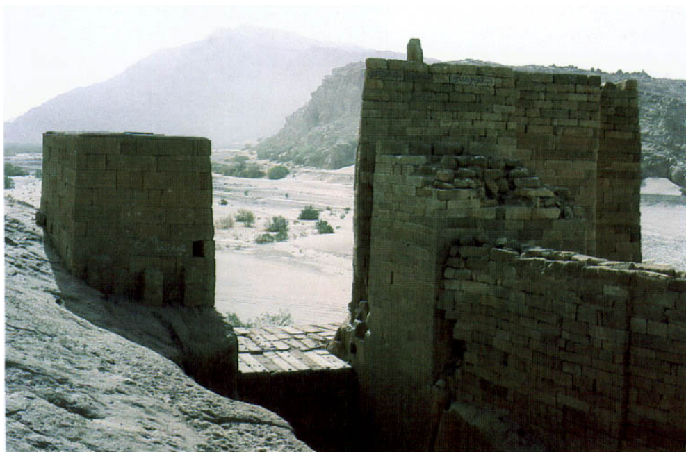
169 - Déversoir du barrage de Mareb (Nord Yemen)
