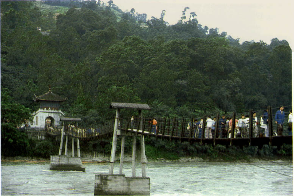
176 - Le Pont suspendu de Li Bing, traverse le Du Jiang et son canal - 250 avant J.C. La forme caténaire du tablier est bien visible
