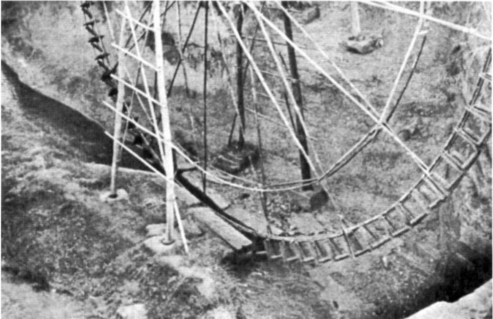
172 - Noria chinoise près de Lanzhou (Gansu). La roue, entièrement en bois et bambou, a 45 pieds de diamètre
