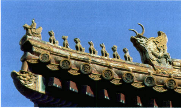
35 - La Cité Interdite détail d'un toit
