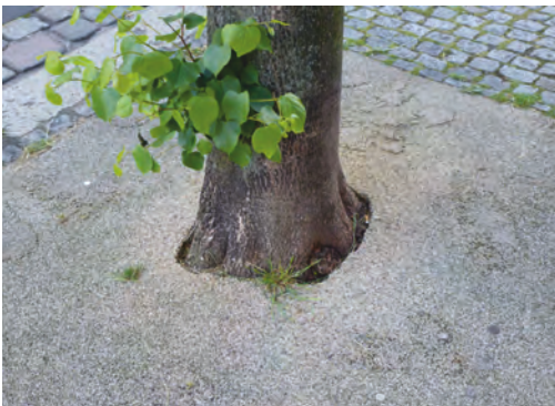
Abb. 6: Kassel Wahlershausen, Wilhelmshöher Allee. Winterlinde in mit Epoxidharz verklebtem Kies zur Unterdrückung von Unkraut, 08.05.2014.
