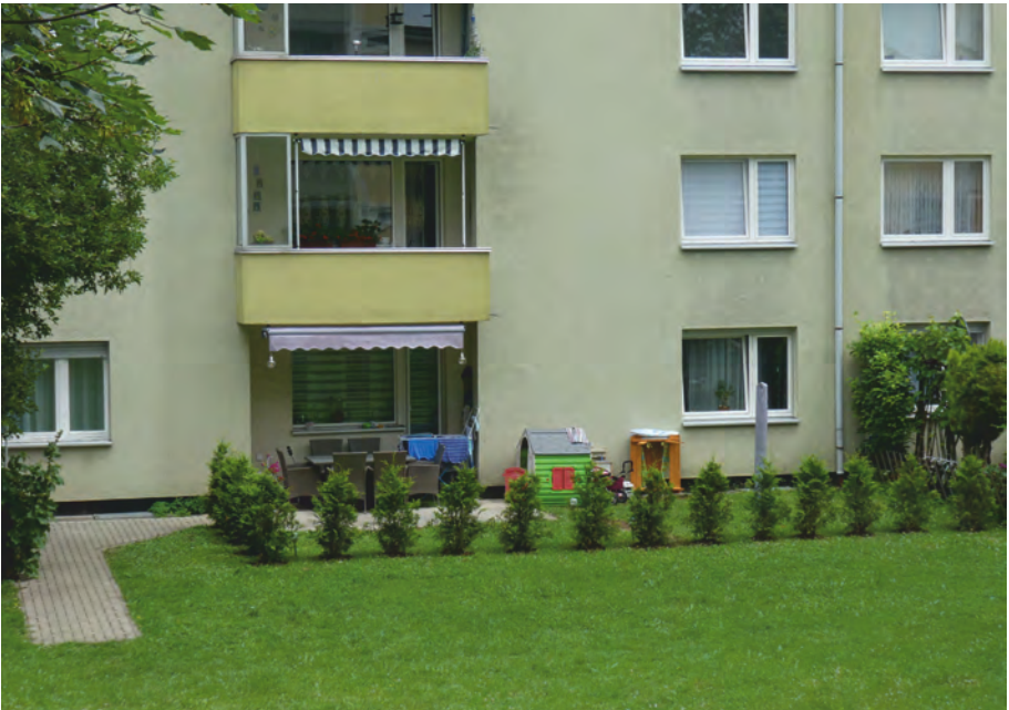
Abb. 1: Kassel Helleböhn. Aneignung des Abstandsgrüns von einer Erdgeschoss-Wohnung aus, auf der dem Eingang gegenüberliegenden Seite mit kleiner Terrasse anstatt Balkon, wie in den Geschossen darüber. Abgrenzung gegenüber Einblicken in den privatisierten Freiraum mit Lebensbaum geplant, 03.07.2020.
