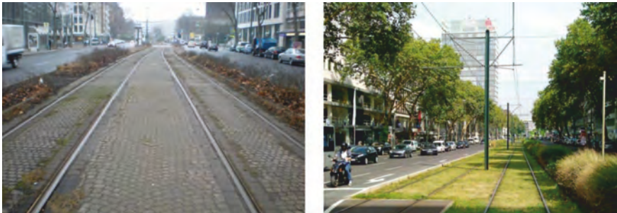
Abb. 5: Erscheinungsbild vor und nach dem Anbau der Gleisbegrünung in Düsseldorf (AHRENS et al. 2014: 17, Quelle: Rheinbahn AG)
