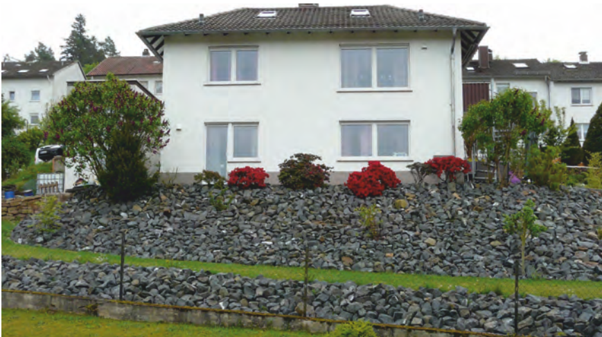
Abb. 7: Schottergarten zur Hangbefestigung (eigenes Foto)
