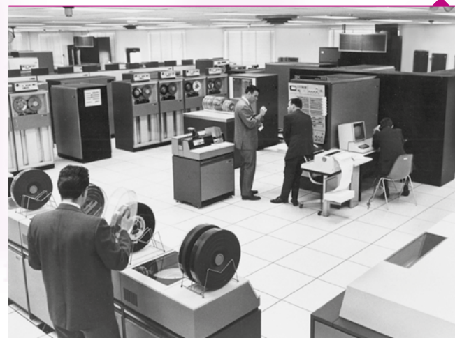
Installation IBM System/360 vers 1965.
