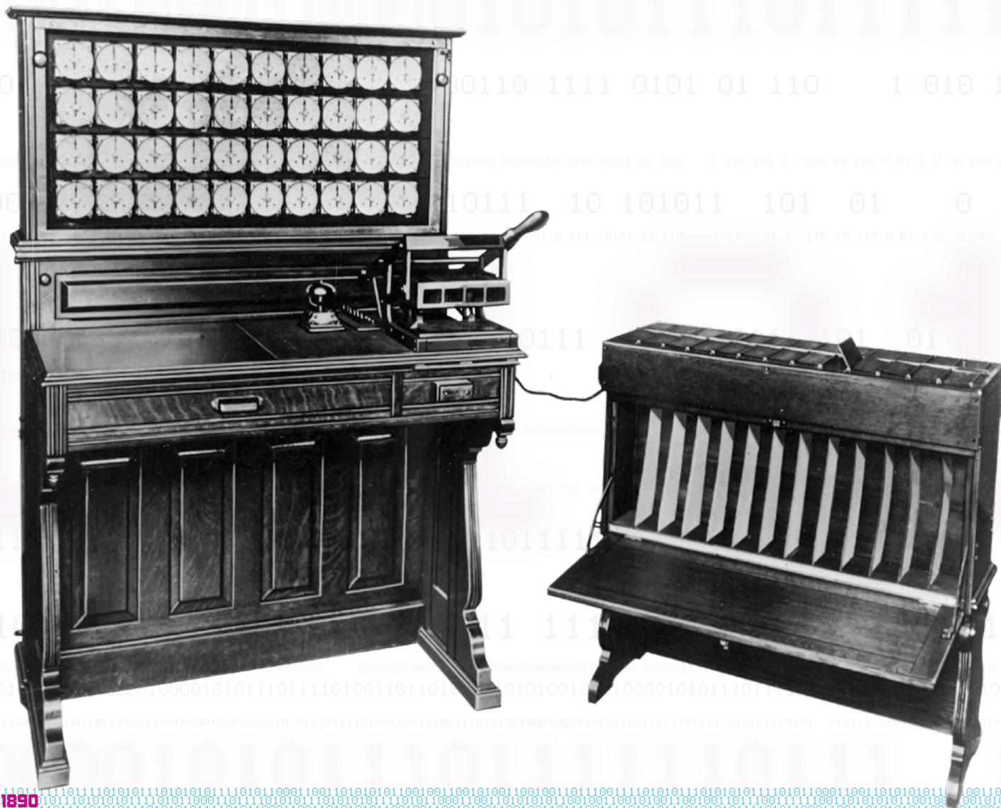
Tabulatrice et trieuse d'Hermann Hollerith utilisées pour le recensement américain de 1890.
