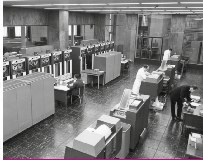
IBM 1440 à la banque de la Société générale de Belgique (1964).
