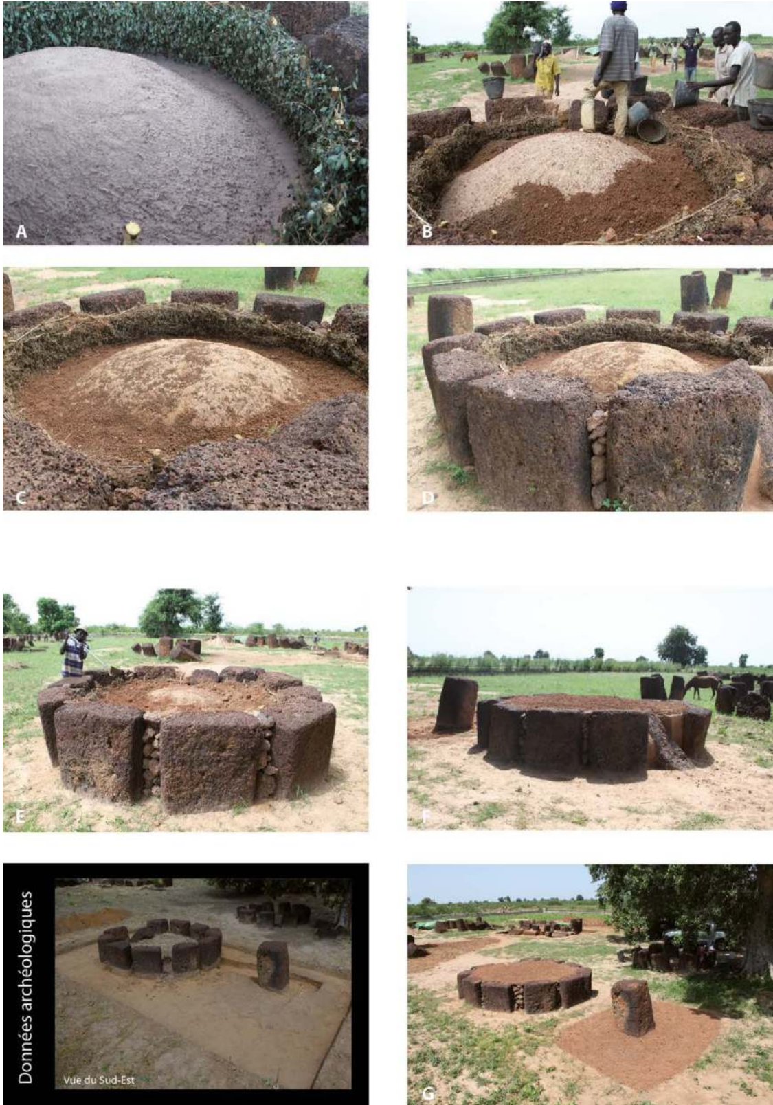
3.3.7 - Fig. 4 : Restauration du monument XIV : comblement sommital de gravillons latéritiques. Des gravillons sont rapportés depuis les carrières, distantes de 300m, pour finaliser le comblement interne du cylindre et réaliser une aire de gravillons autour de la frontale. Clichés L. Laporte.
