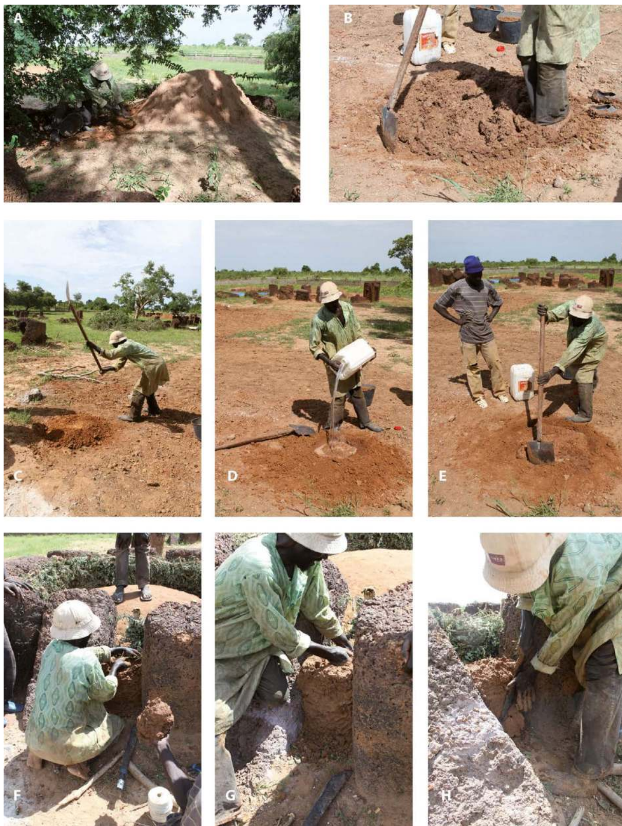
3.3.7 - Fig. 7 : Constructions en terre massive - différentes étapes de la chaîne opératoire : A/ Prélèvement de l'argile dans une termitière, B à E/ Préparation de l'argile, F à H/ Montage d'une première portion de paroi. Cl. L. Laporte
