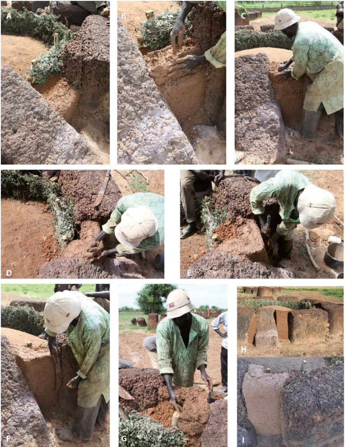
3.3.7 - Fig. 8 : Constructions en terre massive - différentes étapes de la chaîne opératoire : Les opérations de l'étape précédente sont répétées pour les assises supérieures, avec une attention toute particulière pour la partie supérieure, qui sera soumise aux intempéries. Cl. L. Laporte
