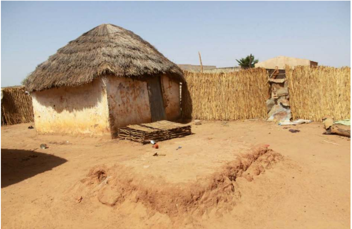
3.5.2 - Fig. 10 - Plateforme en brique de terre crue construite dans la cour d'une concession au sein du village de Wanar.
