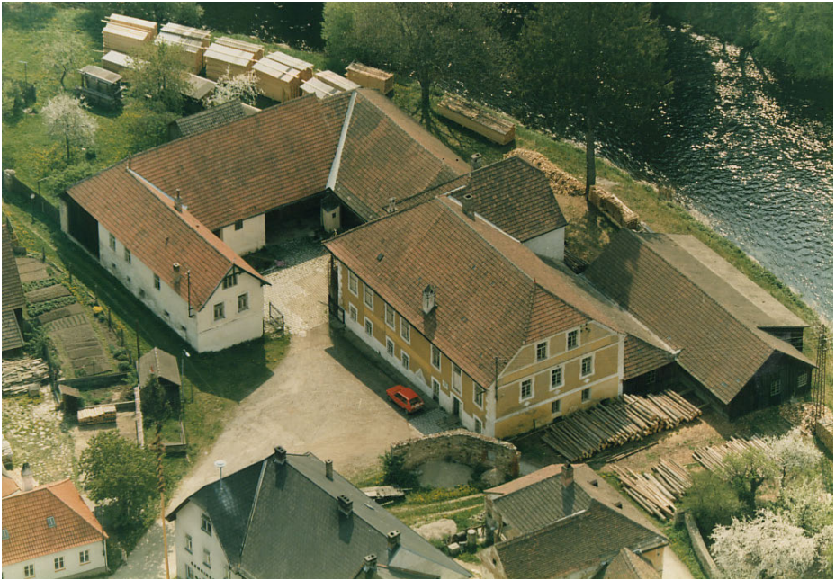
Abbildung 1: Luftbild Mühlenareal vor Kauf und Renovierung (Foto: o.A.)
