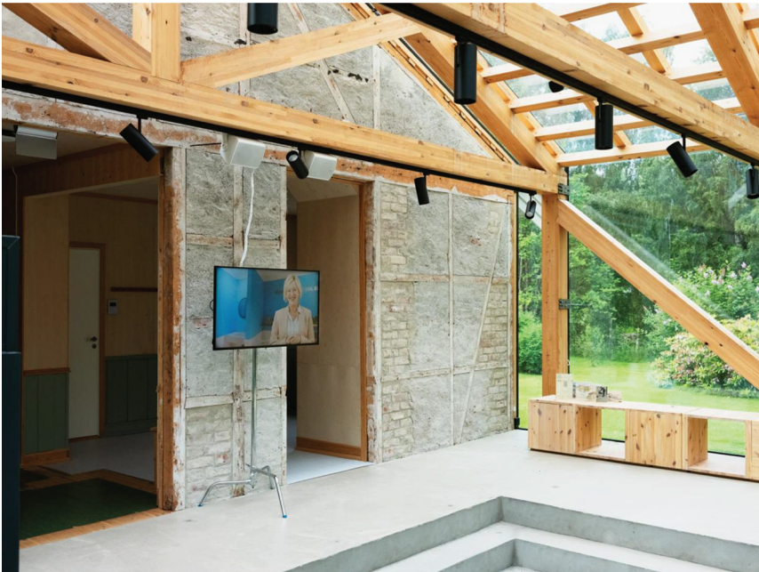
Figur 3. «Where Dreams Come Home» plassert i den påbyggede glassfoajeen, inngangspartiet i kommandantboligen. Bak i bildet er den originale opprinnelig indre bindingsverkmuren som ble bygget av falstadfanger. Øvrige gulv og veggflater er en blanding av originalt fra krigsårene og nyere deler. Foto: Jakob Ganslmeier (2022). Gjengitt med tillatelse fra Jakob Ganslmeier. Alle rettigheter forbeholdt.
