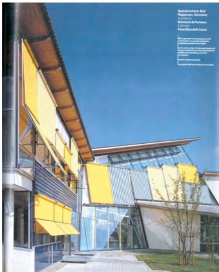
Abb. 29: Albert-Schweizer-Schule, Bad Rap- penau (Deutschland) (1992)
