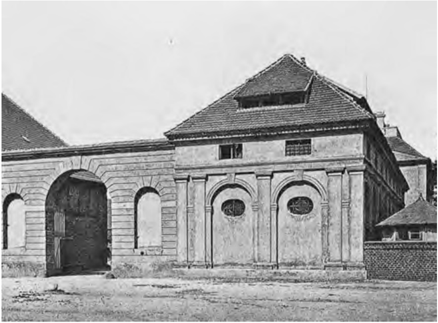
Fig. 11.4: Amtshaus of Wörlitz, side wing, photo before 1947 (source: H. Kleinschmidt, A. Stahl, Das Amt Wörlitz. Geschichte und Baugeschichte [Halle, 2021]).
