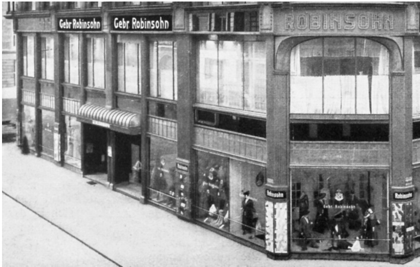
Hausfassade der Firma Gebr. Robinsohn an der Schleusenbrücke (Ausschnitt)
