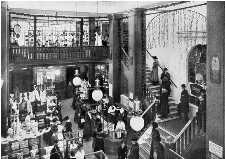
Der Treppenaufgang im Haus 31-33
