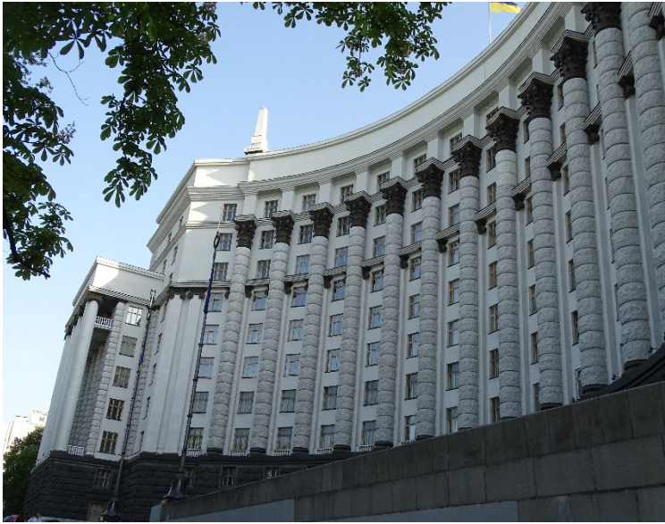
Abb. 62: Regierungsgebäude der Ukraine
