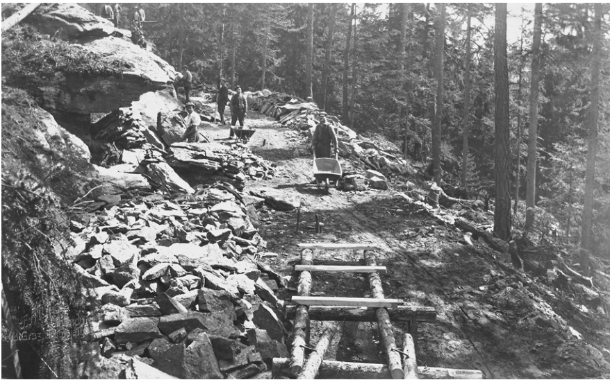
Bauarbeiten Packer Stausee im Steinbruch. Foto Allmann, Graz.
