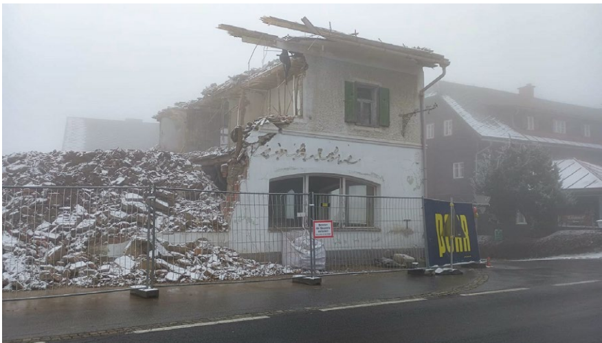
Abriss Gasthof Packerhöhe, Februar 2025
