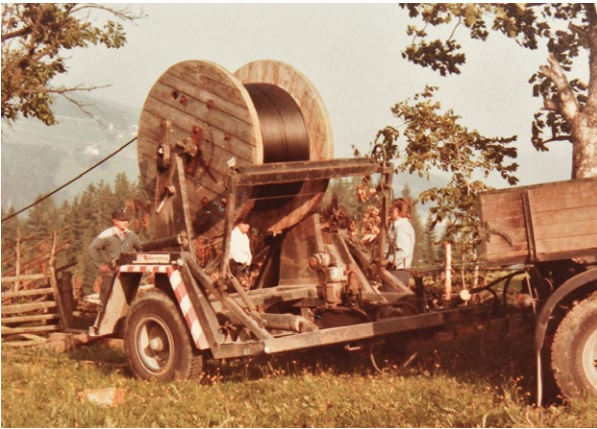
Verlegung des Telefonkabels 1982.
