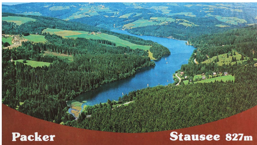
Packer Stausee; am linken Bildrand ist der Bau der Südautobahn A2 zu sehen.
