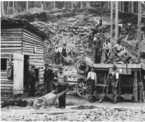
Arbeiter bei der Schotterquetsche für das „Steinbrechen“ für den Straßenbau auf der Hebalm, 1935.
