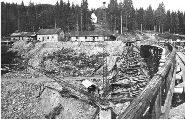
Baustelle Packer Stausee, ca. 1930. Foto Allmann, Graz.
