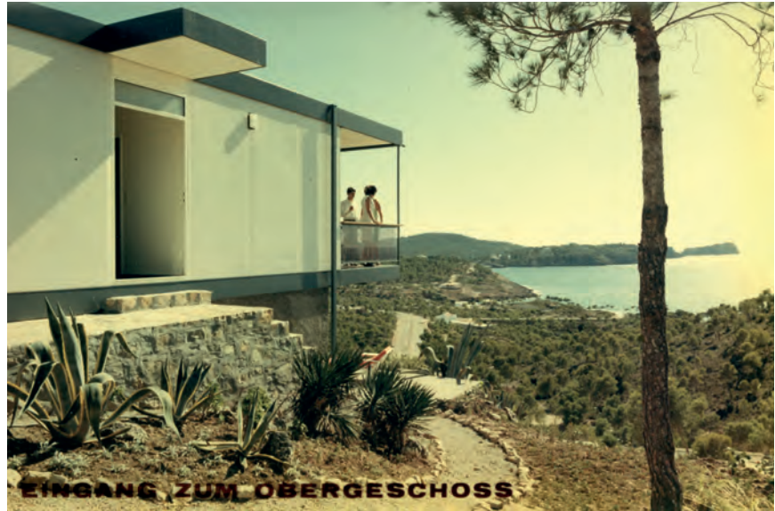
Abb. 67: Eingang zum Obergeschoss des Test-Bungalows, Abbildung mit darüberliegender Schriftfolie in der Schrift zum „Hoesch Test Bungalow Mallorca“, um 1965/66.
