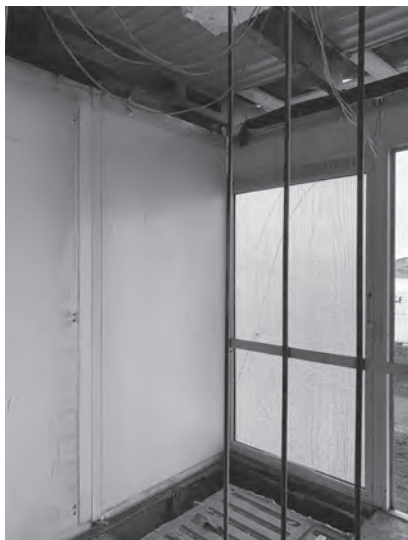
Abb. 83: Detailaufnahme des Eingangsbereichs von Haus L 141 während der Reparatur auf dem Gelände des Hoesch-Museums, Dortmund, 07.12.2022, mit geöffneter Decke.
