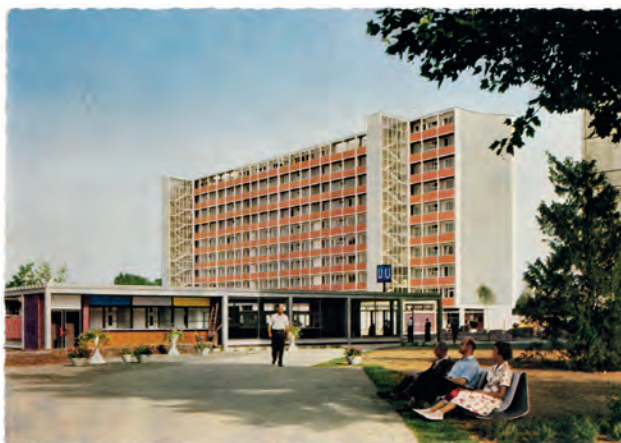
Abb. 27: Ansichtskarte mit dem sogenannten Schwedenhaus, entworfen von Fritz Jaenecke und Sten Samuelson unter Mitarbeit von Erich Heyne für die Internationale Bauausstellung (Interbau) Berlin 1957 im Hansaviertel, Ansicht von Nordwesten, o. D.
