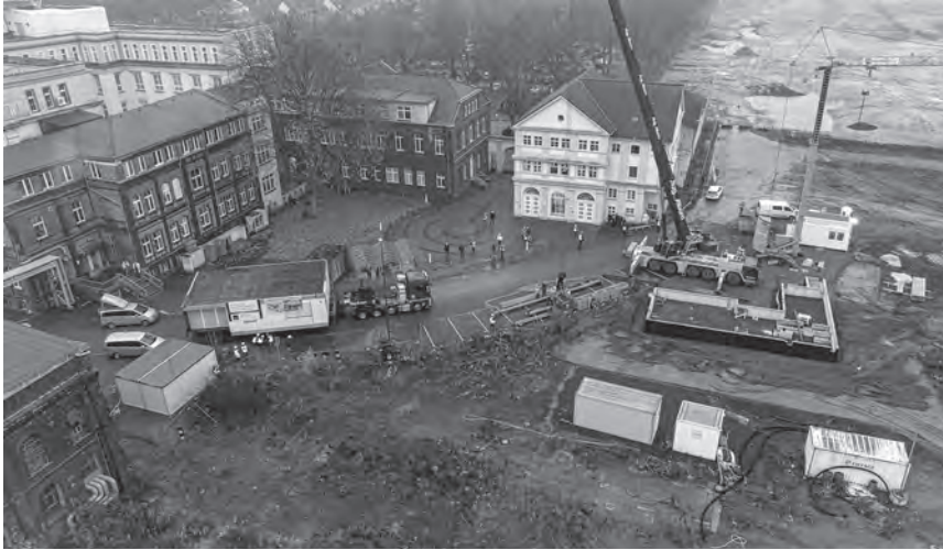
Abb. 18: L 141 auf der Zielgerade. Rechts im Bild zu sehen: das neue Fundament für das Stahlhaus, 2022.
