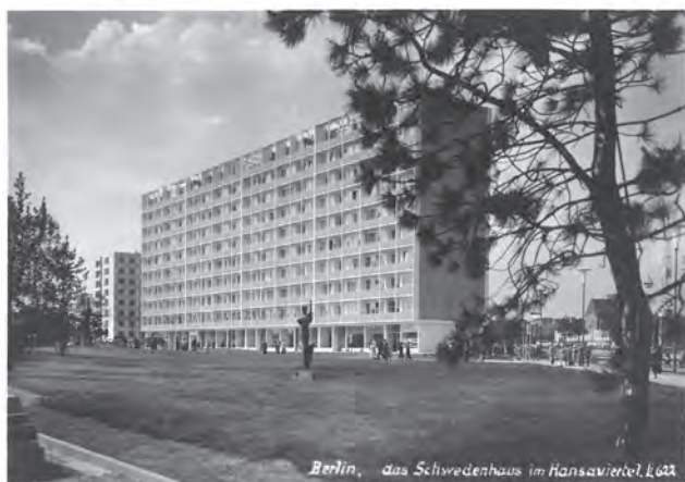
Abb. 26: Ansichtskarte mit dem sogenannten Schwedenhaus, entworfen von Fritz Jaenecke und Sten Samuelson unter Mitarbeit von Erich Heyne für die Internationale Bauausstellung (Interbau) Berlin 1957 im Hansaviertel, Ansicht von Südosten, o. D.
