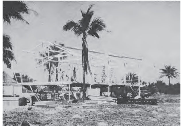
Abb. 16: Hoesch-Haus – Gästehaus der Regierung in Conakry, Guinea, Montage vor Ort, abgebildet in Heft 2, 1964, der Zeitschrift „Werk und Wir“.
