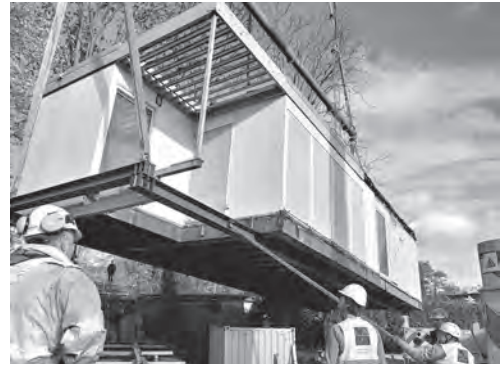
Abb. 14: Ein Teil des L 141 am Haken, 2022.
