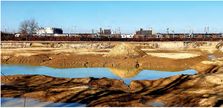
Abb. 13: Umfangreiche Erdbewegungsmaßnahmen waren nötig, um die Industriebrache für die Projekte Karlsquartier, Stahlhaus und Grüner Ring vorzubereiten, 2022.
