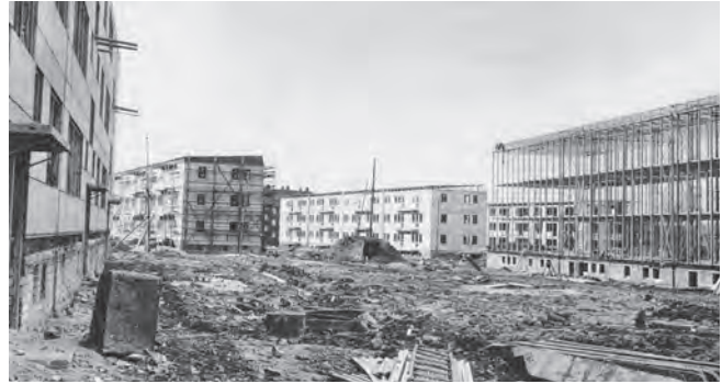
Abb. 32: Siedlung an der Bischoffstraße in Altenessen im Bau, um 1962.
