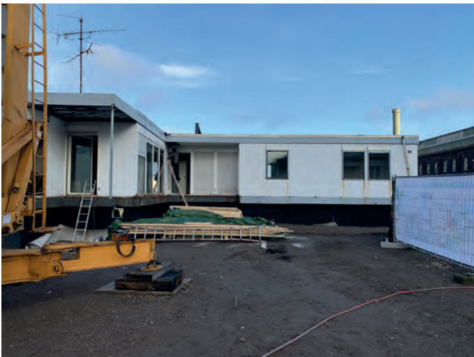
Abb. 82: Außenaufnahme von Haus L 141 während der Reparatur auf dem Gelände des Hoesch-Museums, Dortmund, 07.12.2022.
