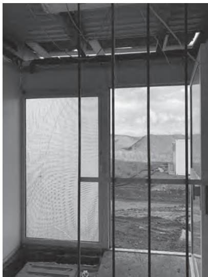
Abb. 84: Detailaufnahme des Eingangsbereichs von Haus L 141 während der Reparatur auf dem Gelände des Hoesch-Museums, Dortmund, 07.12.2022, mit geöffneter Decke und Boden und Blick auf die Profile und Sickenbleche.
