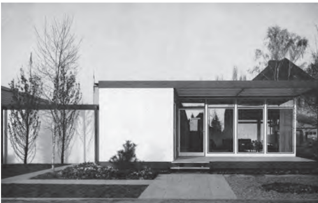
Abb. 70: Vorgefertigter Bungalow aus Stahl in Hannover, Vorderseite, ohne nähere Verortung in einer Publikation der Beratungsstelle für Stahlverwendung 1962.
