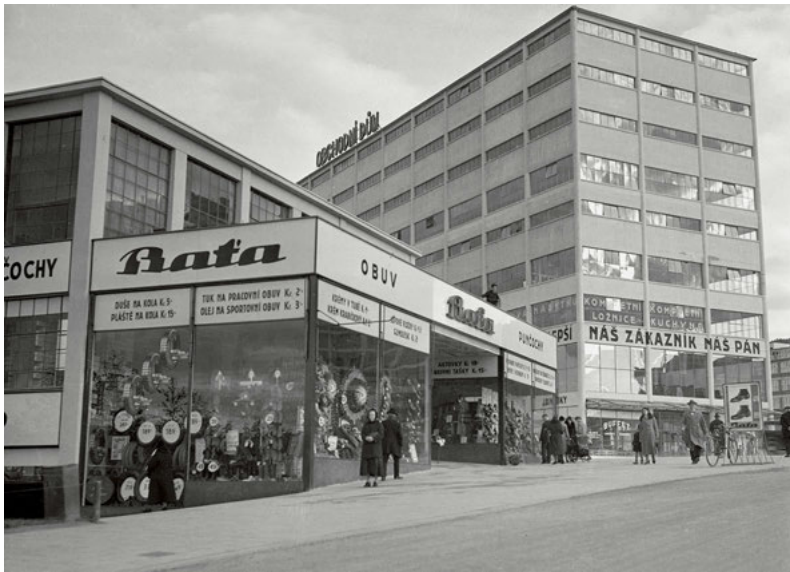
Abbildung 15: Blick auf den Platz der Arbeit mit Handelshaus ( Obchodní dům ) und Verkaufshalle, 1936.
