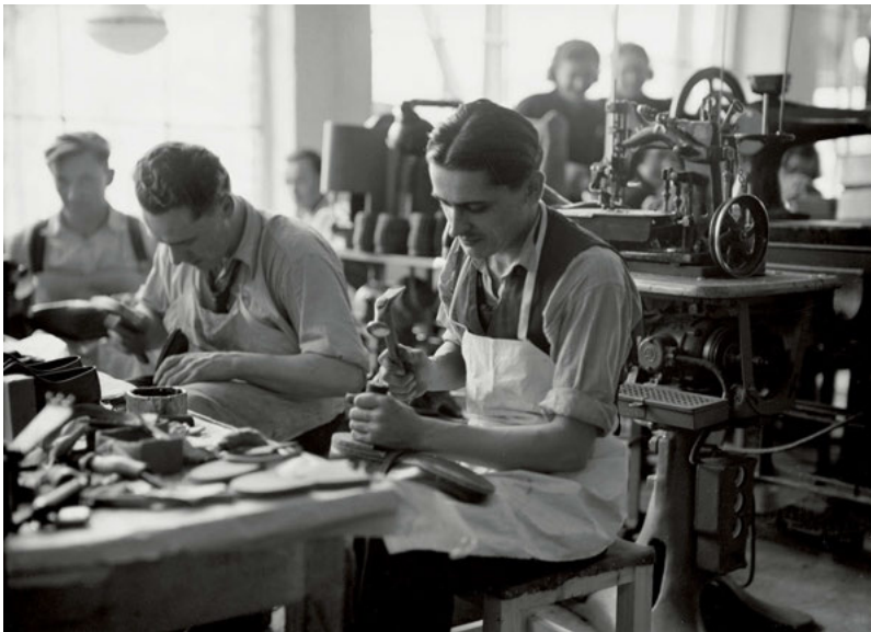
Abbildung 6: Arbeiter in der Werkhalle bei der handwerklichen Schuhherstellung, hier dem Nageln von Absätzen.
