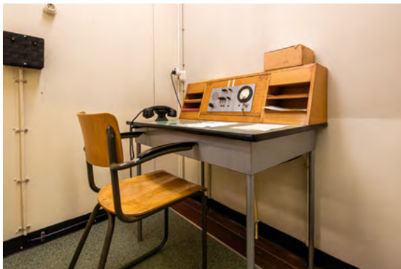
14 Schakeltafel voor de bediening van de B.B.- sirenes.
