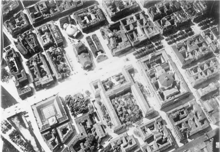
Fig. 12.33 Berlin, aerial view Opernplatz, Unter den Linden. January 1, 1935.
