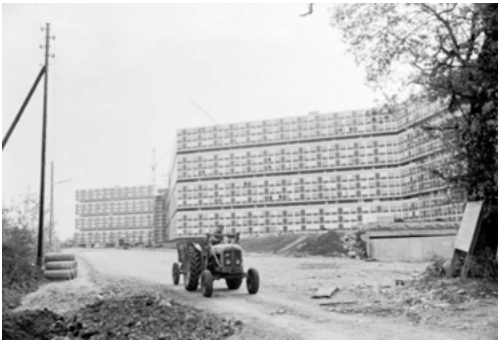
Abbildungen 3 und 4: Bauen auf der »grünen Wiese«, Cité du Lignon in Vernier, Genève (1963-71 gebaut), Nov. 1966
