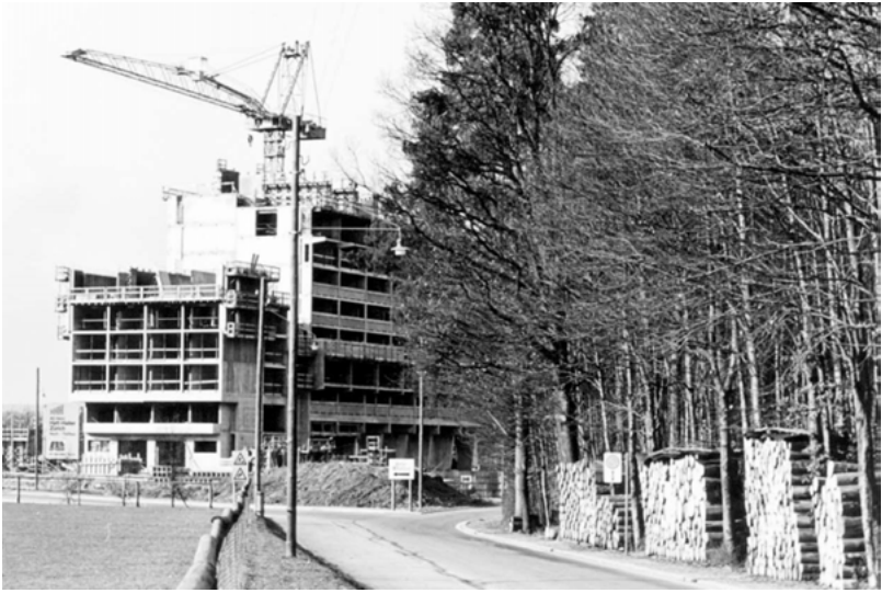
Abbildung 28: Unteraffoltern II im Bau, 1968
