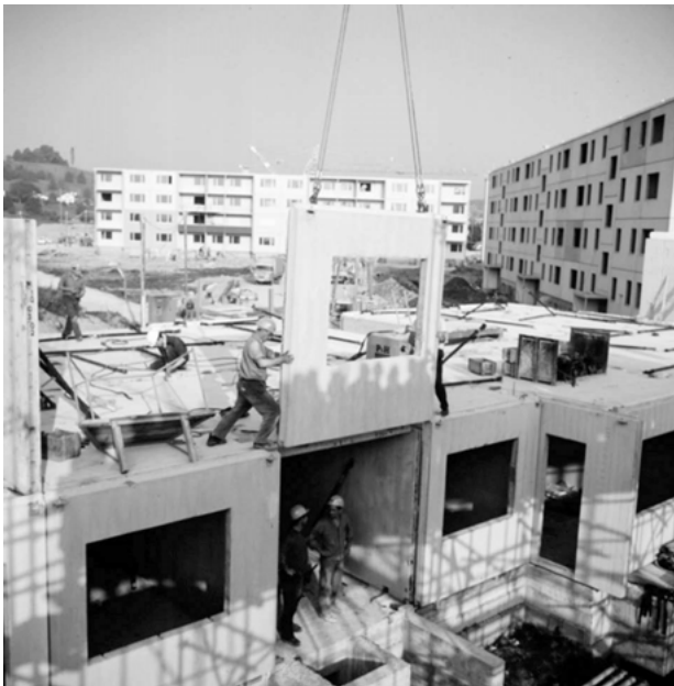
Abbildung 6 und 7: Vorfabrizierter Wohnungsbau der Göhner AG, Baustelle mit raumhohen Betonelementen, September 1966
