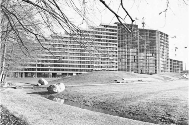
Abbildung 75: Wohnzeile A im Bau, 1972
