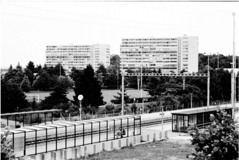
Abbildung 33: Blick vom Bahnhof Affoltern, 1999
