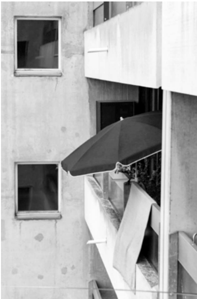
Abbildungen 105 und 106: Balkon als privater Regenerationsraum
