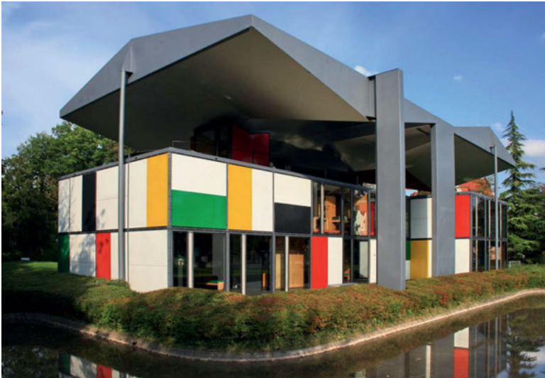
Fig. 7: Le Corbusier, Centre Le Corbusier, Zurich, 1967.
