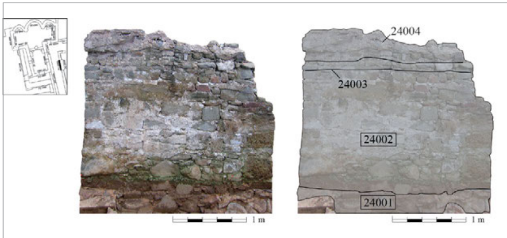
fig. 9 – Particolare della porzione di muratura presente nel chiostro, interpretata come la base dell'originario campanile a vela.
