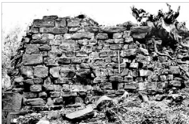
fig. 95 – Perimetrale orientale della torre.
