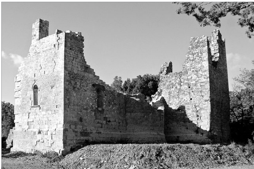
fig. 12 – Monastero di Monteverdi. Veduta dell'abside e del transetto meridionale della chiesa con, in secondo piano, la torre.
