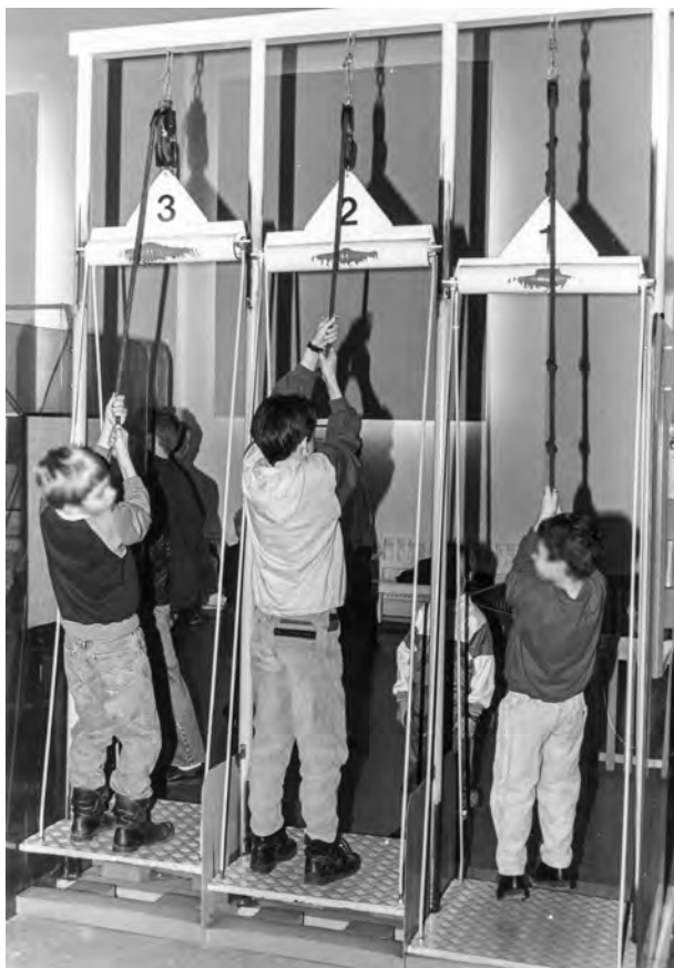
Bild 20. Teknorama I – Upptäcka, Utforska, Uppleva från 1992. Stationen ”Lyft Dig Själv” innebar enkla hissordningar där besökaren kunde lyfta sig själv med hjälp av ett, två eller fyra block. (Foto: Kay Danielsson/Tekniska museet)
