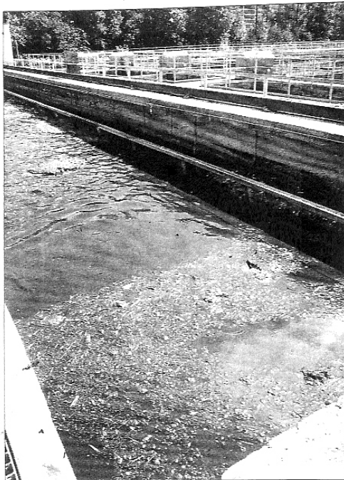
Blominmäen lietementtu täyttyi pian. Jatkossa Suomenojan liete ajetaan todennäköisesti Ammässuolle.
