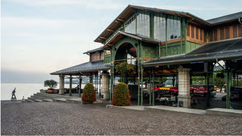
Figure 46. Le marché couvert de Montreux. Source : Markus Bühler-Rasom.
