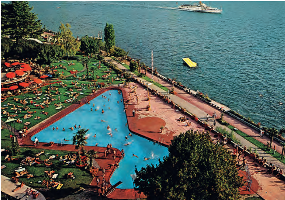
Figure 93. La piscine du casino. Carte postale. Source : Collection privée.
