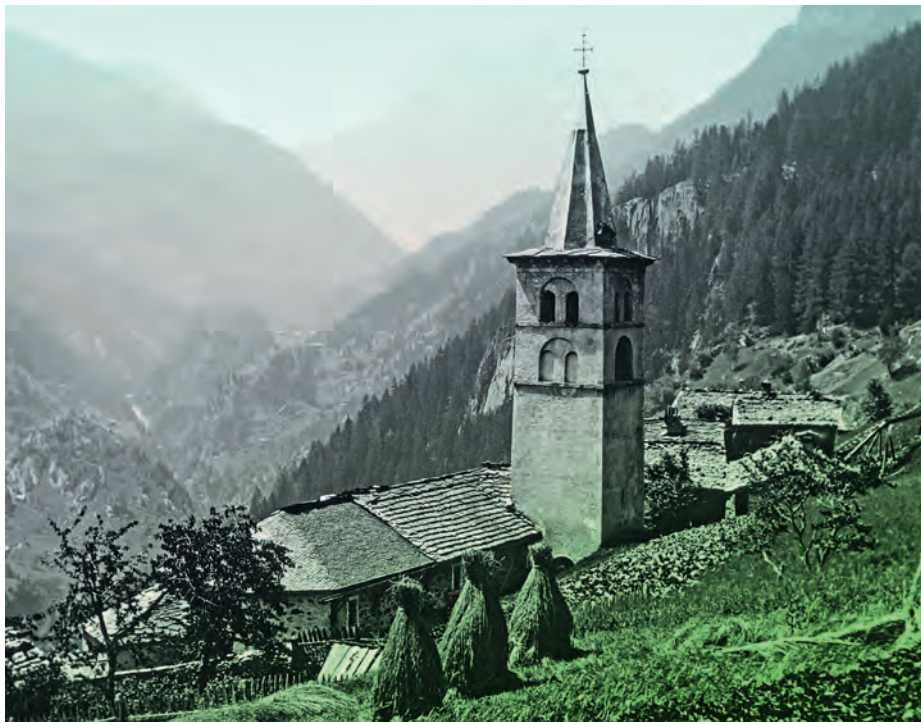
Figure 35. L'ancienne église de Finhaut. Vue vers le sud-ouest. Carte postale. Source : Collection privée.
